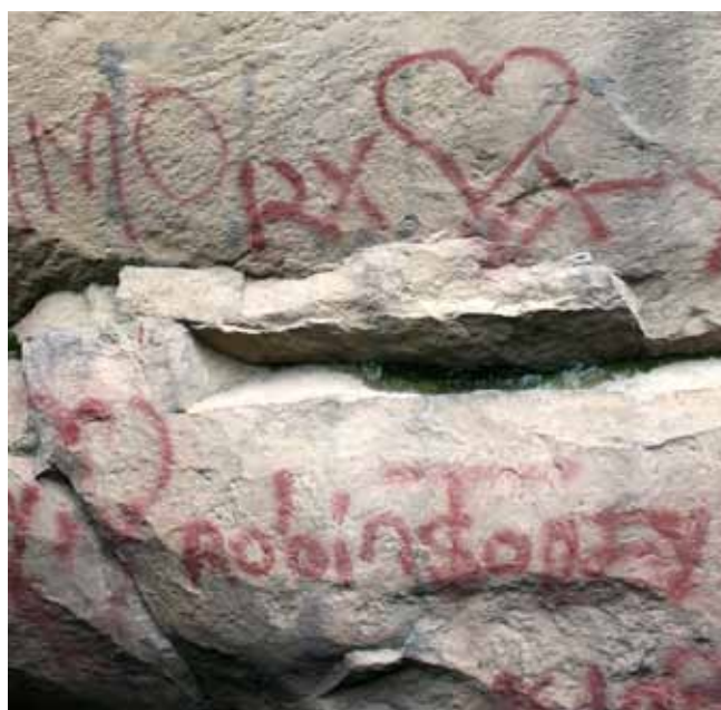
Alteración de un mural con pintura rupestre en el cerro de San Mateo en Soacha mediante la inscripción de graffiti con pintura en aerosol.
