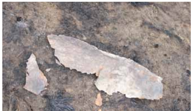
Desprendimiento de la superficie pétreo por fluctuación fuerte de temperatura causada por el incendio. Foto: Diego Martínez Celis, 2014
