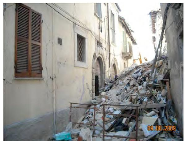
Fig. 10 : Eboulement de bâtiment en maçonnerie
