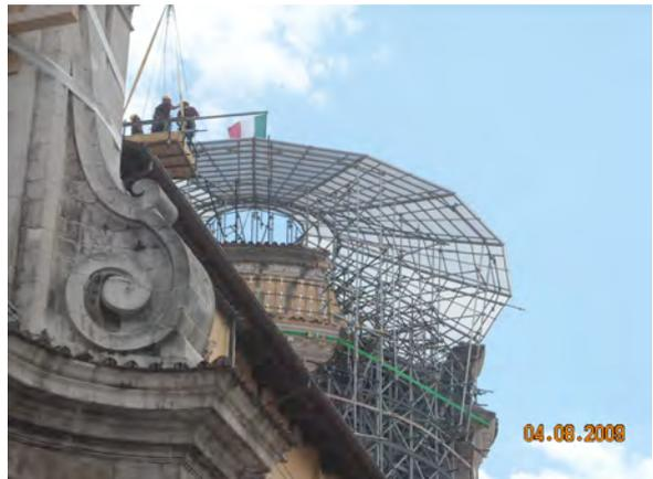
Fig. 20 : mise en securité de la coupole du Suffragio
