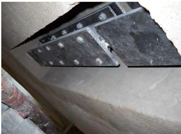
Fig. 24 : détail du dissipateur en acier
