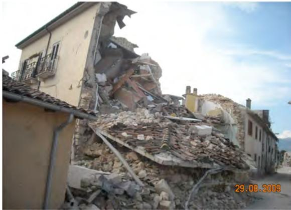
Fig. 11 : Eboulement de bâtiment en maçonnerie
