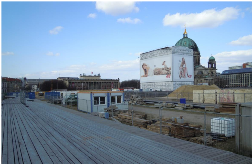
Illustration n°23 : Le chantier de reconstruction du château de Berlin. En arrière plan l'échafaudage de la future Humboldt Box . L' Altes Museum en arrière plan.
