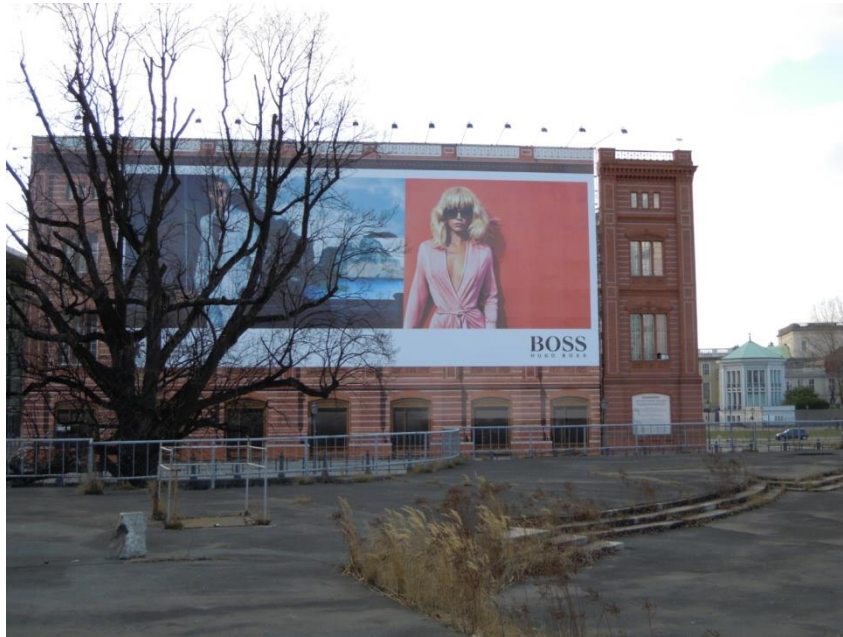
Illustration n°22 : Reconstruction de la Bauakadémie de Berlin, des bâches recouvrent les échafaudages.
