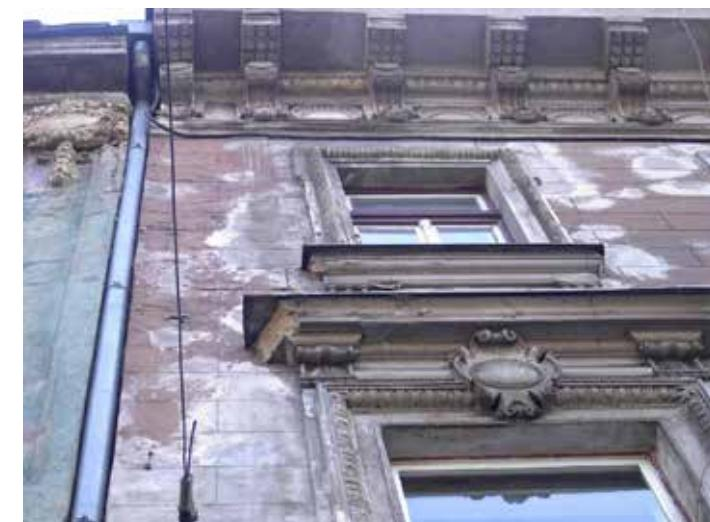
**Ilustracija 3.** Fasada jednog od objekata u Titovoј ulici. Stanje prije početka izrade projekta konzervatorsko-restauratorskih radova. Oštećenja bojenog sloja i malternih površina nastala uslijed povećanog dejstva vlage i oštećenja dekorativne plastike.
