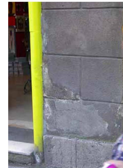
**Ilustracija 4.** Fasada objekta u Titovoј ulici. Stanje prije početka izrade projekta konzervatorsko-restauratorskih radova. Fizička ostećenja nastala kao rezultat izmjene portala.
