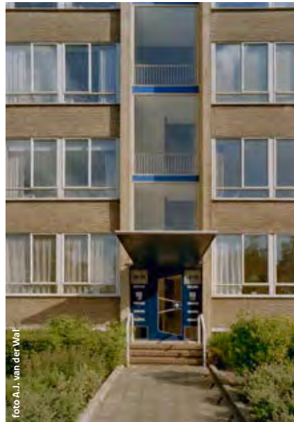
linksboven Rijtjeshuizen in Klein Driene. linksmidden De 'zaagtandwoningen' in de Westelijke Tuinsteden. linksonder Portieketageflat in de Atlantikwallzone in Den Haag. rechtsboven Portieketageflat aan de Sportlaan, Mariahoeve Den Haag. rechtsonder Splitlevelwoningen aan de Luxemburgwoningen in 't Hooft.
