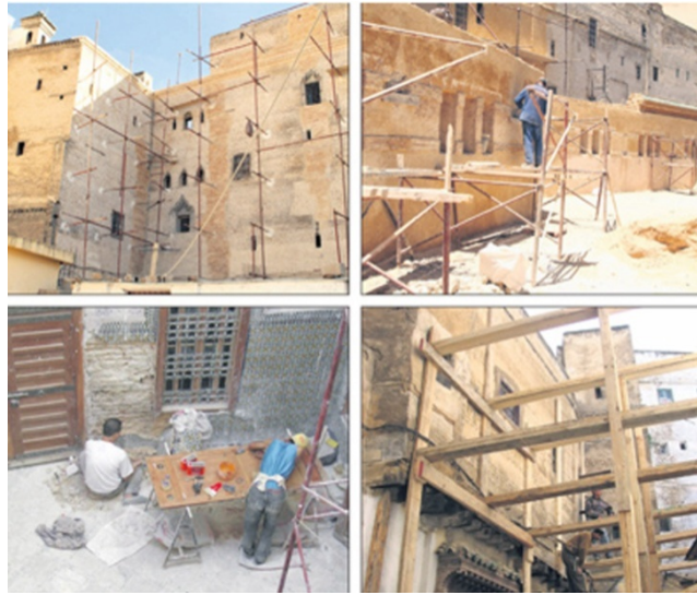
Fig.3- Constructions réhabilitées dans la médina de Fès (ADER-Fès, 2008)
