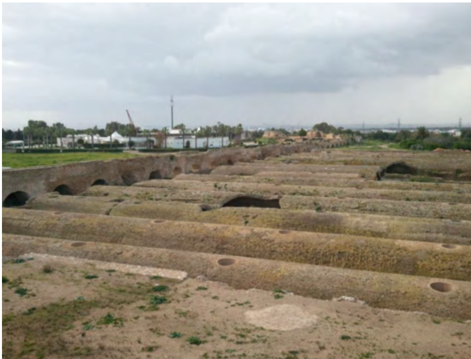
Carthage (Tunisie). Aqueduc et citernes de Maalga (en arrière-plan lotissement 'sauvage' au contact du site). Photo UNESCO-ICOMOS, 2012
