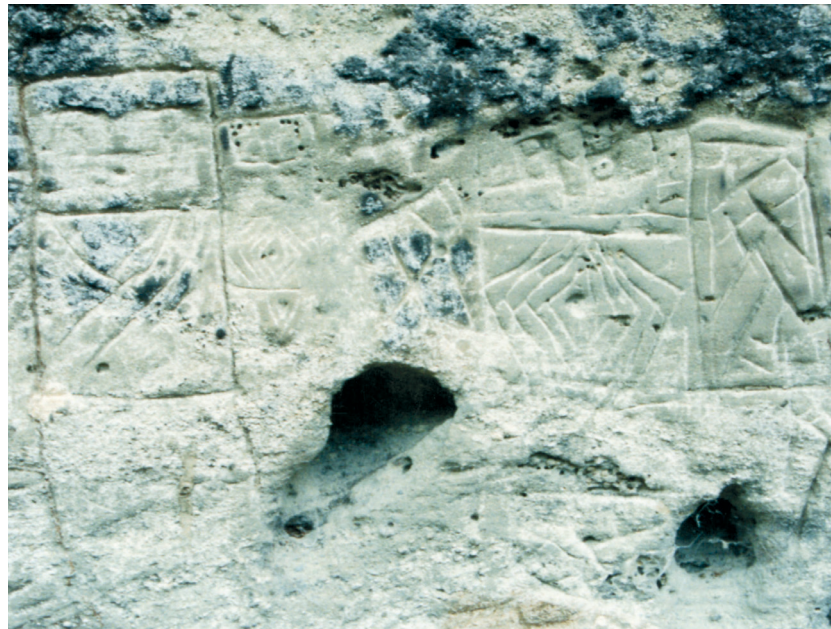
Figura 3.1.14. Grupo 4 (detalle). Nótese el disgregamiento de la pátina original (oscura) de la superficie. Foto: Diego Martínez C. 1998
