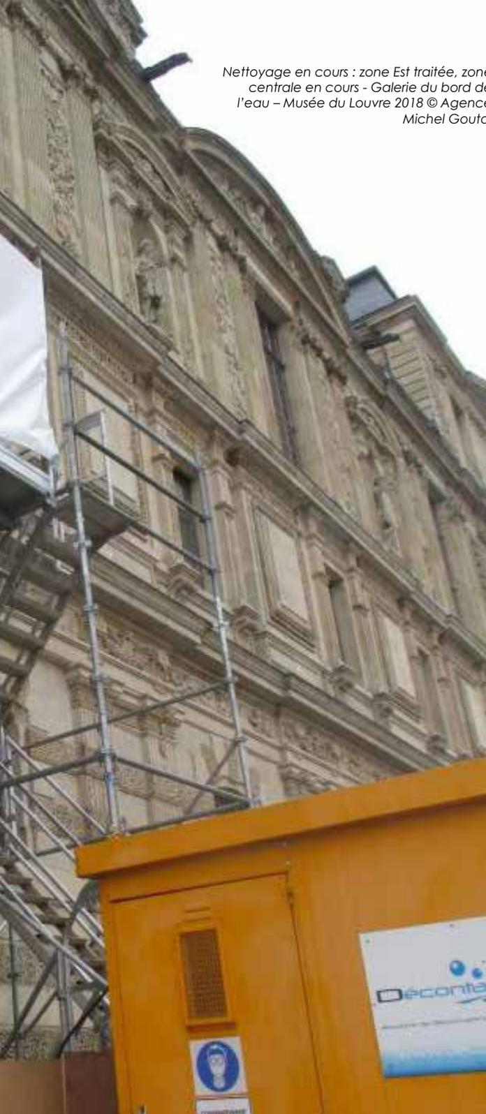
Le nettoyage des parements a été fait par l'application d'un cataplasme à base d'argile verte hydrophile.
