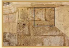
شكل (3): الثقوب التي كانت تستخدم لتثبيت الألواح الرخامية على الواجهة Figure (3): Holes used to fix the marble panels on the facade
