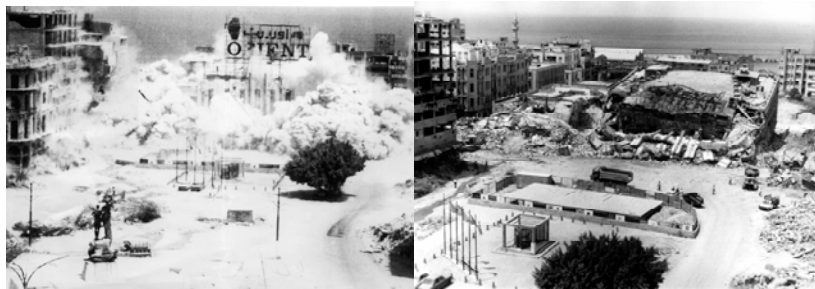
Image 3 et 4. La démolition du cinéma Rivoli
