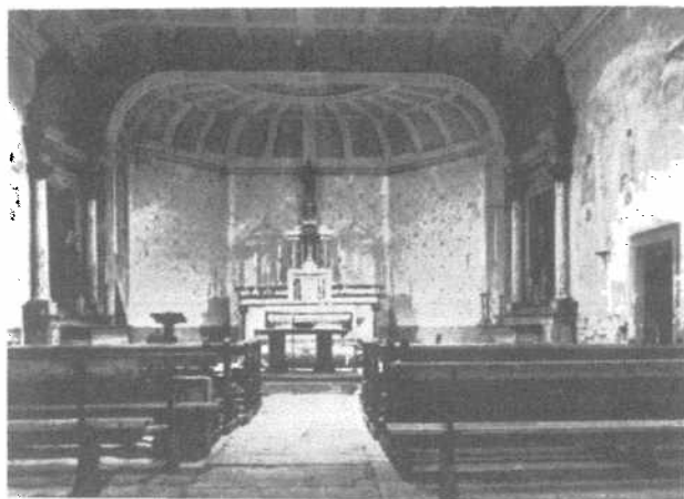
Eglise paroissiale de Cuvat (Haute-Savoie). Avant les travaux. (Photo « Comité d'Art Sacré »).
