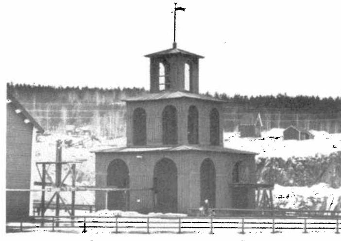
Les bâtiments construits aux abords de la mine à ciel ouvert datent pour la plupart du XIX<sup>e</sup> siècle. Ce chevalement fut achevé en 1850. Les arbres que l'on voit sur la gauche, actionnaient deux pompes dans le puits. Ils ont été récemment reconstruits.
