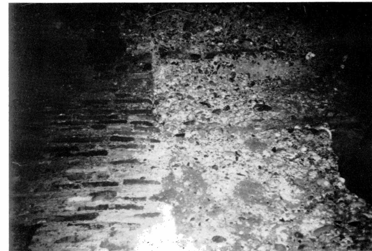
L'Hôtel de ville de Gaillac (Tarn department, France), construit en 1833 par Lebrun : une des toutes premières utilisations du béton dans l'architecture civile : béton de chaux hydraulique constituant les fondations.
