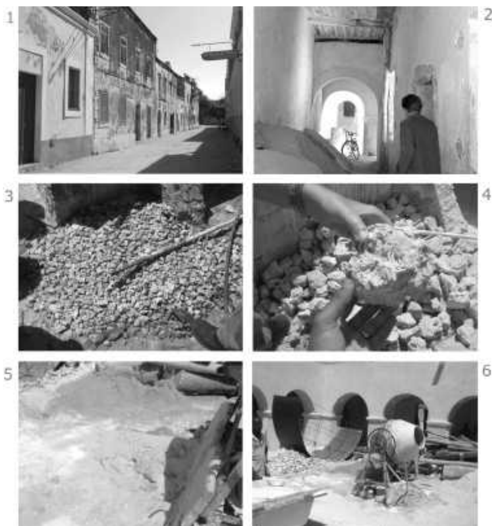
Fig. 20 (a) Restauro de uma antiga casa-feitoria em Ilha de Moçambique. Externo e vão de acesso à casa (1 e 2). Os muros apresentavam-se em condições de desfazimento em algumas partes da casa e por isto foi preciso recorrer à extração de alvenaria calcária de uma antiga pedreira não fóssil na costa de terra firme. O material foi reduzido em blocos de maior e menor tamanho, conforme os cálculos de projecto. Com o emprego dos blocos de maiores dimensões foram completados os muro onde faltavam blocos (4), enquanto que com as peças menores diminuíram-se os buracos causadas pela dissolução das argamassas de aleitamento devida à re-formação cíclica dos sais (3). As argamassas necessárias para os aleitamentos nos assentamentos de muros, para os estuques mais profundos e para o acabamento são confeccionadas no canteiro com o emprego de areia de rio, cal apagada de produção industrial nacional e água doce.
