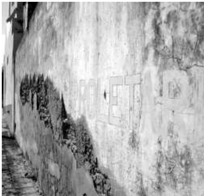
Fig. 13 A presença desta escrita mural explica algumas consequências temporais nos rebocos do muro e a dimensão temporária do ciclo de degradação dos próprios rebocos e do muro.
