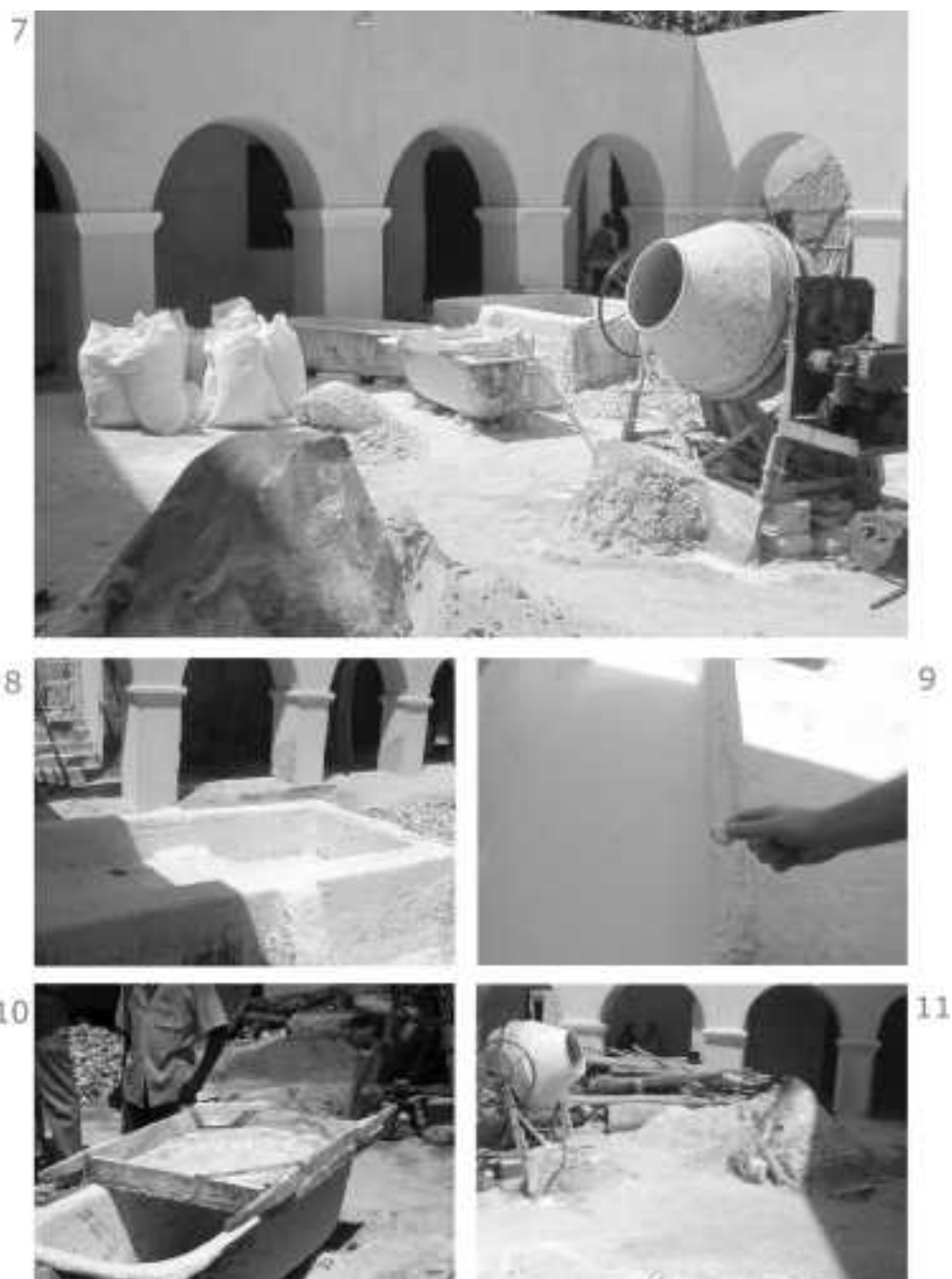
Fig. 20 (b) Restauro de uma antiga casa-feitoria em Ilha de Moçambique. Houve cuidados especiais no canteiro de obras para a extinção da cal ( \text{CaO} ou cal viva) fornecida em sacos pela fábrica (7). O pó de cal viva é derramado num tanque de extinção onde se acrescenta água e, segundo a reacção química \text{CaO} + \text{H}_2\text{O} = \text{Ca}(\text{OH})_2 , torna-se cal apagada, ou seja Hidrato de cálcio. À medida em que é preciso produzir uma determinada quantidade de argamassa para trabalhos em andamento, a cal apagada é retirada do tanque de extinção e avaliada através da malha de um crivo a fim de interceptar eventuais grumos de cal não apagada que poderia reagir provocando danos quando o empaste já tiver sido aplicado (7, 8 e 9). Com o objectivo de obter um reboco de porosidade muito fina também avalia-se com o crivo a areia que, como a cal, não pode apresentar impurezas (10 e 11).
