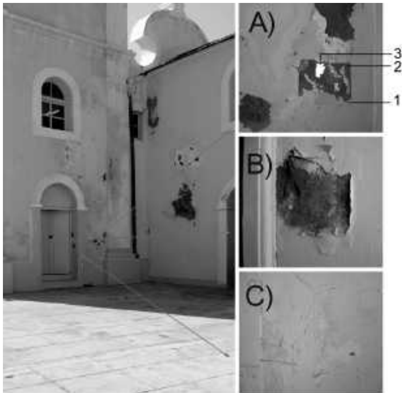
Fig. 14 A) Três camadas de tinta por cima de um reboco que parece, à primeira vista, uma integração dum tempo passado e do qual não foi possível estabelecer a extensão em relação à parede toda. B) O mesmo tipo de reboco encontrado no ensaio precedente. Esta integração do reboco não parece de modo nenhum composto de cimento, parece mais um empaste com areia de pozolana; se isto se confirmasse, este caso teria um certo interesse histórico-científico. C) Do ponto de vista estreitamente conservativo deste monumento arquitectónico, a aplicação no restauro mais recente duma tinta sintética não piorou muito o quadro da acção da humidade salina no muro.
