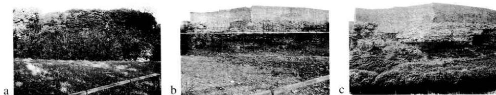
Fig. 3 Esterno del bastione di S. Prodocimo, minato in epoca napoleonica. Tre fasi delle opere di manutenzione: a) prima del diserbamento; b) rimossa la vegetazione; c) a riprese e reintegrazioni effettuate.
