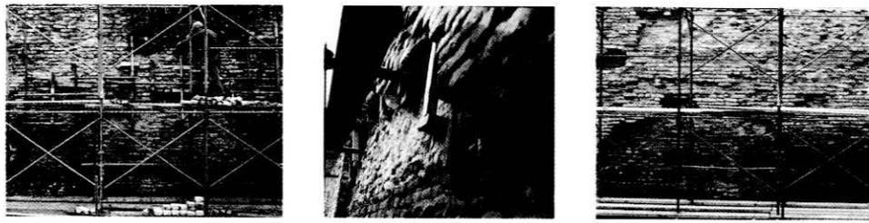
Fig 4 Tre fasi di lavoro nel consolidamento della camicia esterna della cortina muraria laterizia a due teste: si notino i mattoni posti di testa, come 'diatoni', a sostegno, non solo provvisorio, delle parti di camicia superstiti quando questa non viene ripresa e reintegrata.
