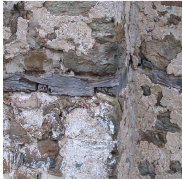
تصاویر شماره ۱: سنگ‌تراش در ساختار یک ساختمان مسکونی در وراستاما، روستایی در شرق تسالونیک که به‌منظور تقویت ساختمان در برابر زلزله به‌کاربرده شده است (محقق، ۲۰۱۳).
