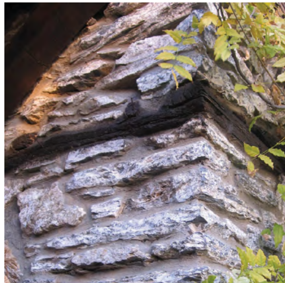
تصاویر شماره ۱: سنگ‌تراش در ساختار یک ساختمان مسکونی در وراستاما، روستایی در شرق تسالونیک که به‌منظور تقویت ساختمان در برابر زلزله به‌کاربرده شده است (محقق، ۲۰۱۳).
