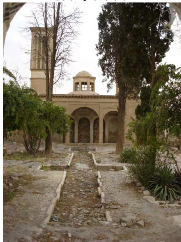
تصویر شماره ۳: نمایی از حیاط شرقی خانه شترگلو ماهان.
