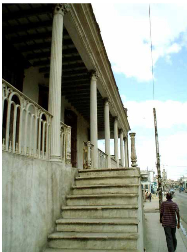
Fig. 3 Calzada del Cerro
