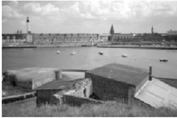
Le fort Risban défendant le port de Calais, de Vauban, jusqu'à la dernière guerre Ph. : Étienne Poncelet.
