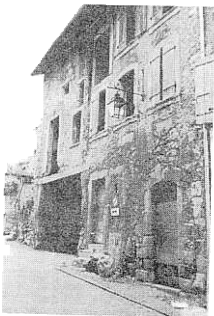
Façade ouest, avant restauration
