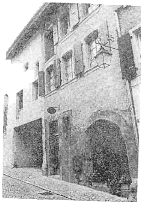
Façade ouest, après restauration
