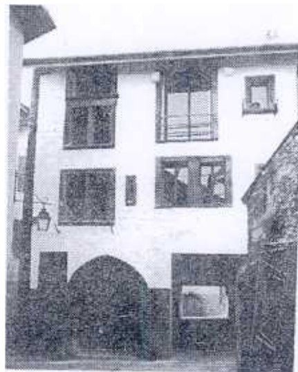
Façade est, après restauration
