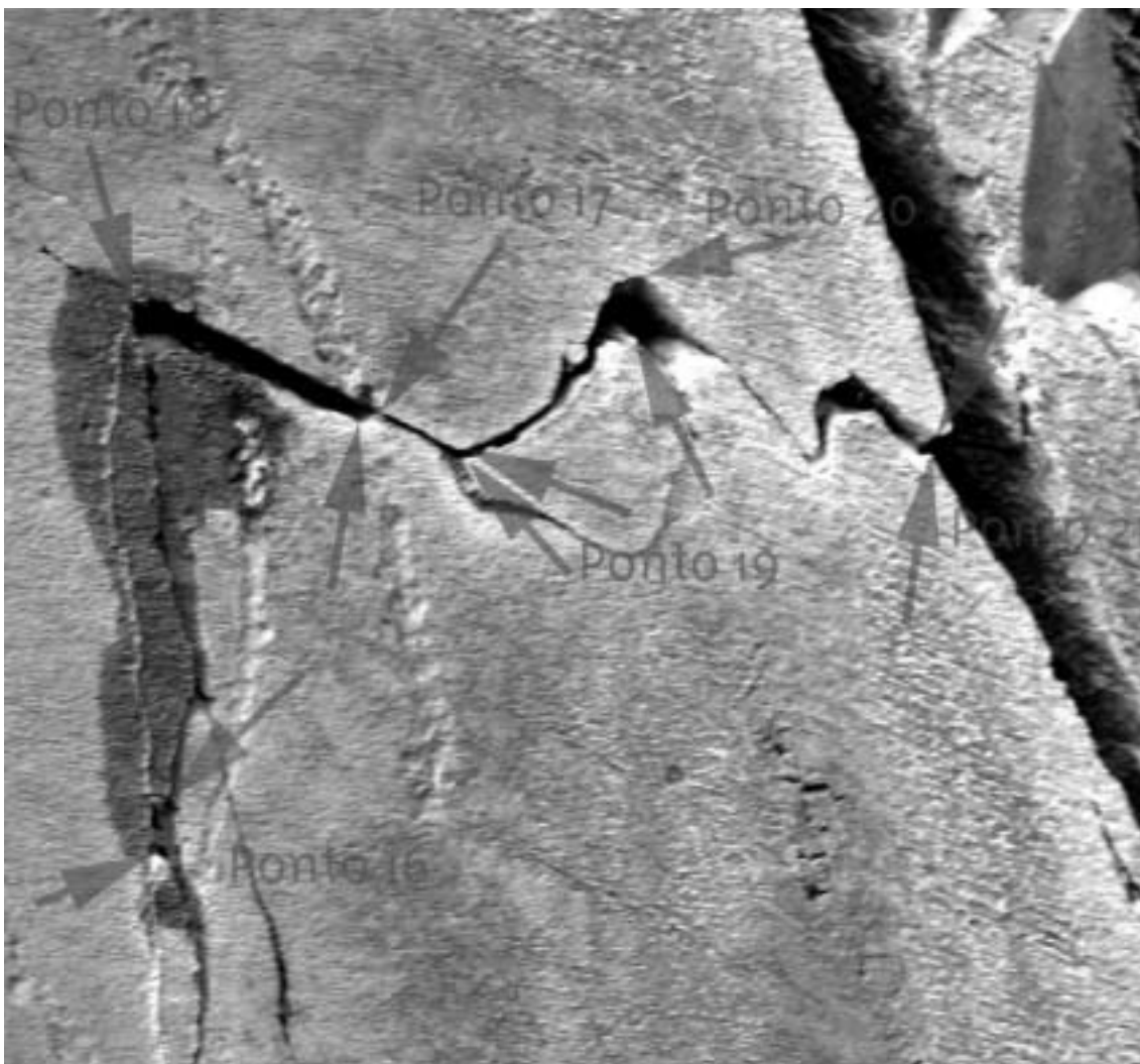
Fig. 7 Pormenor da cartografagem digital de pontos para medição dos movimentos de um painel gravado, neste caso a Rocha 1 da Ribeira de Piscos. De realçar que o original é de muito melhor qualidade, permitindo assim uma correcta referência. De referir que a zona mais sombria entre os pontos 18 e 16 corresponde a um corrimento natural de origem pluvial.
