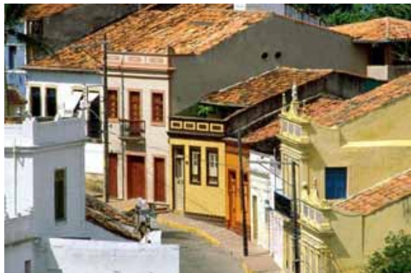
Foto 8: Casa térrea apresentando alteração da morfologia das empenas laterais e das linhas de cumeeira e frechal, além da interrupção da água frontal do telhado (Fonte: imagens.google.com.br).
