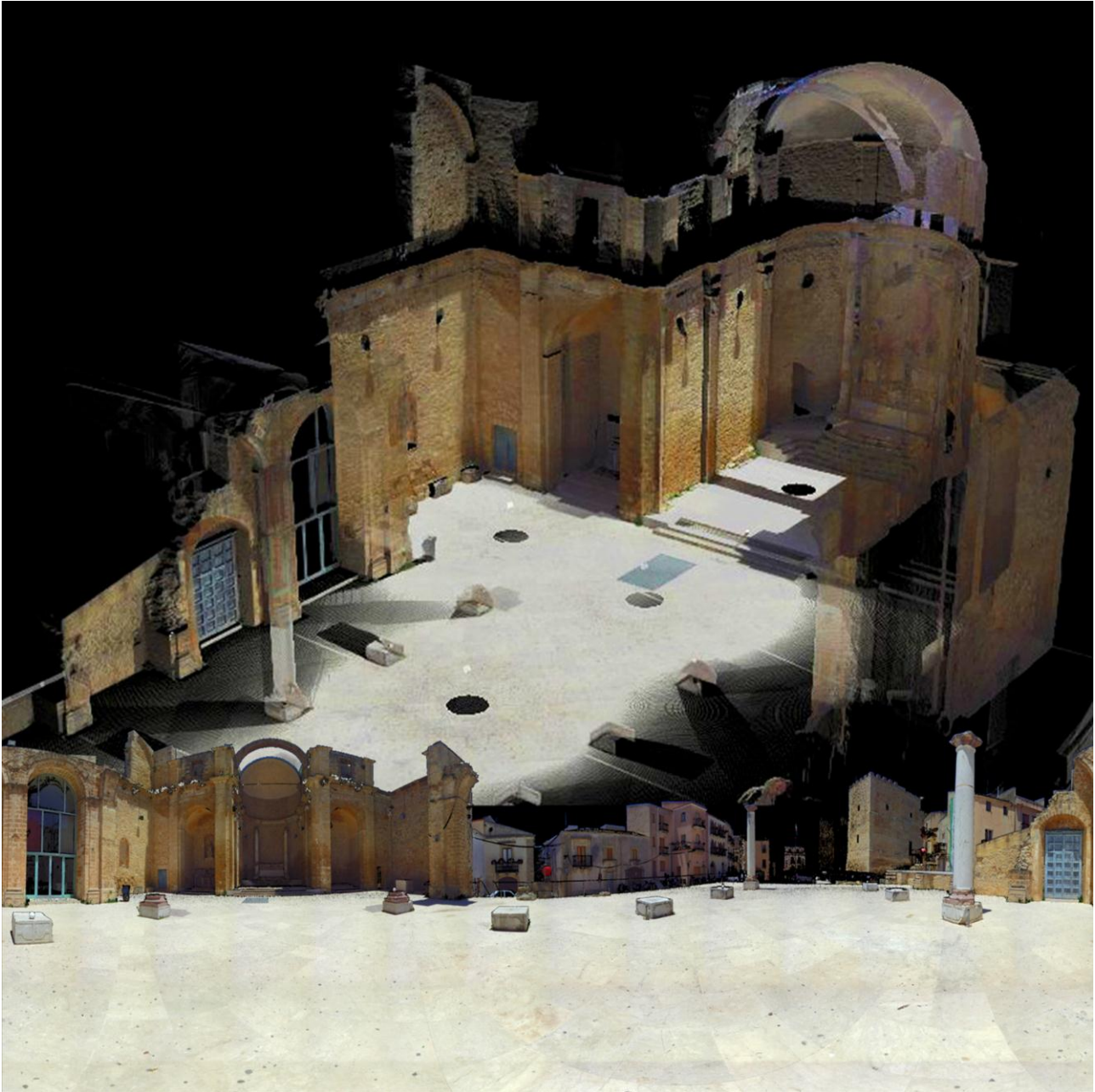
Figura 3 - Chiesa Madre di Salemi (Restauro arch. Alvaro Siza) Nuvola di punti dopo il processo di “caratterizzazione”
