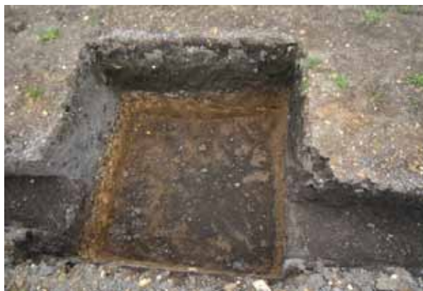
Foto 10. Zapata y excavación para viga de amarre
