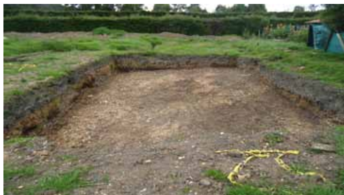
Foto 15. Excavación para la piscina tal como se encontró en el primer reconocimiento.
