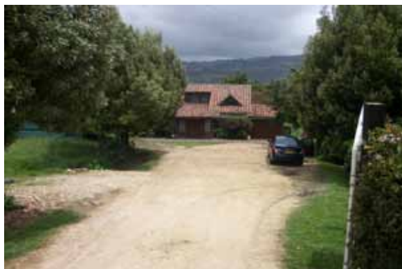
Foto 8. Entrada Casa de habitación El Muelle . Hoy Bugarvillia .
