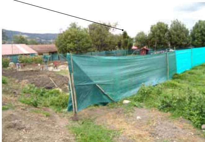
Foto 14. Vista de la excavación de 2012 desde mismo lugar (aprox.) de la foto 13.
