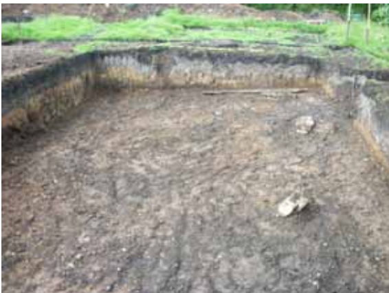
Foto 5. Excavación para la piscina
