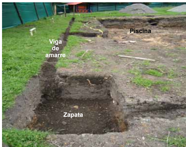
Foto 11. Excavación de zapatas, viga y Piscina
