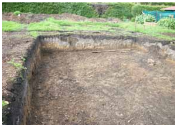
Foto 9. Excavación para la piscina
