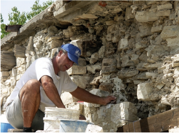
Reconstruction de la maçonnerie endommagée
