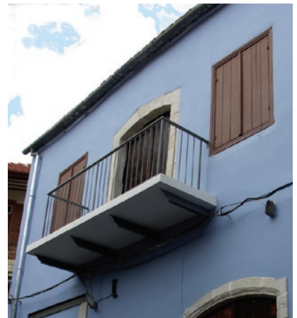
Situation après travaux
