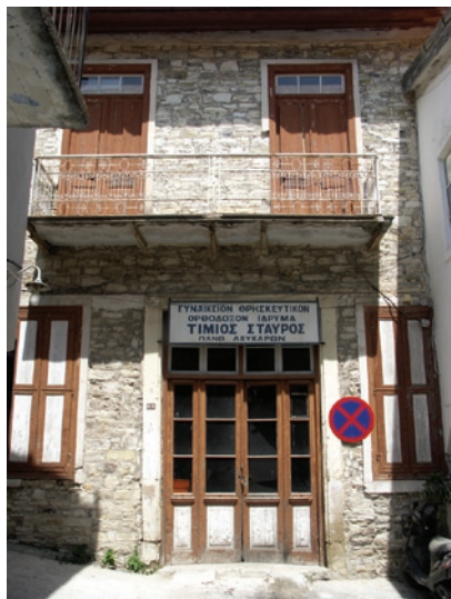
Enduit retiré de la façade
