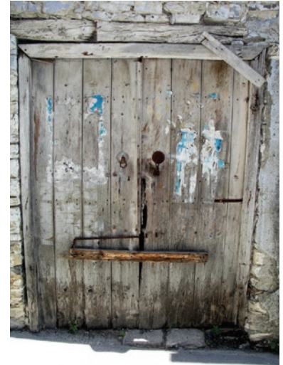
Vieille porte avant réparation
