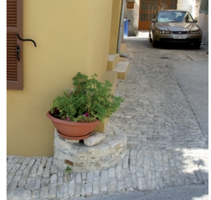
Situation après les travaux
