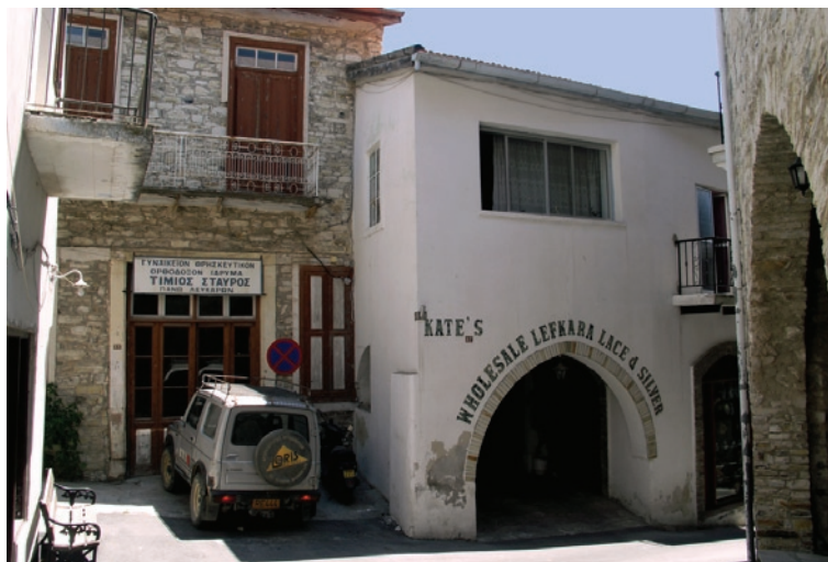
Altérations sur les façades par les interventions récentes
