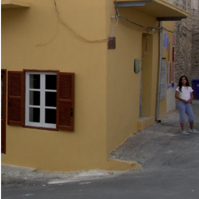
La situation avant les travaux
