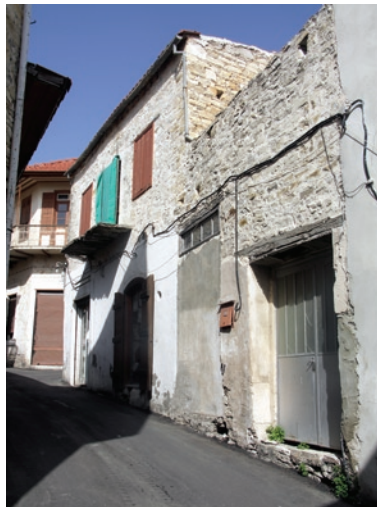
Situation avant les travaux
