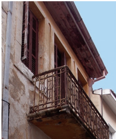
Situation avant travaux
