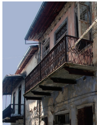
Éléments constructifs et pathologies sur les façades
