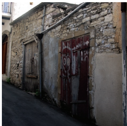
Façades avant travaux
