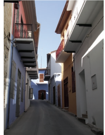
Situation après les travaux
