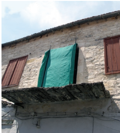
Situation avant travaux
