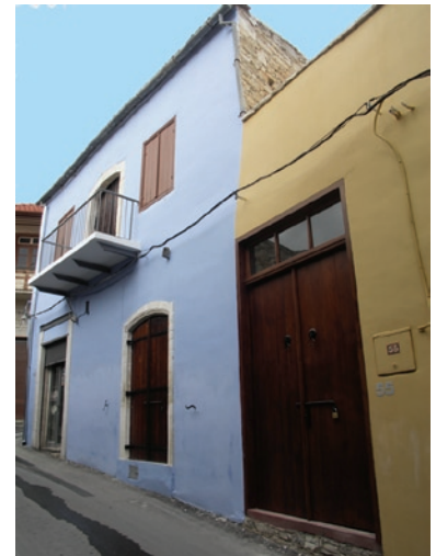
Situation après les travaux
