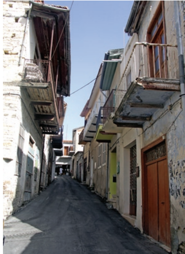
Situation avant les travaux
