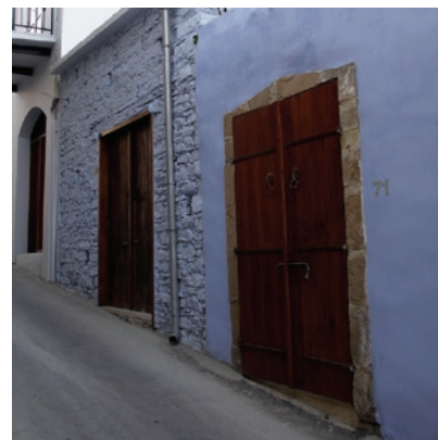
Façades après travaux
