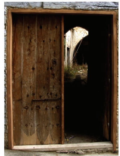
La porte après réparation
