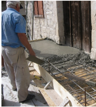
Reconstruction du balcon
