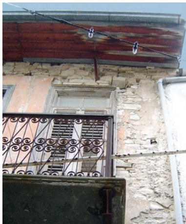
Situation avant travaux
