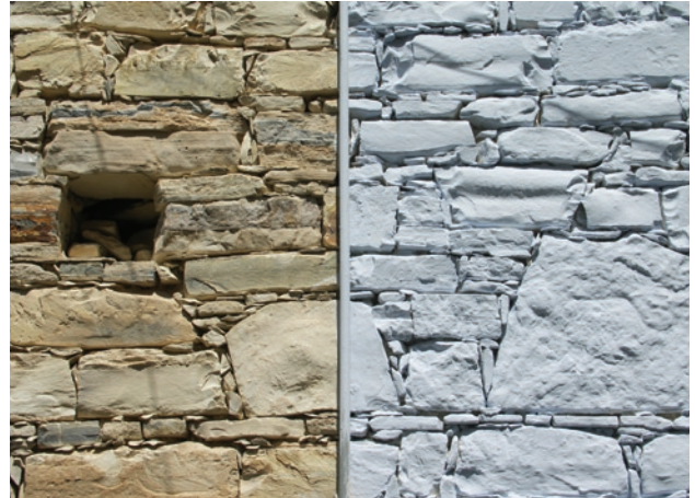
Maçonnerie de pierre et badigeon loulaki
