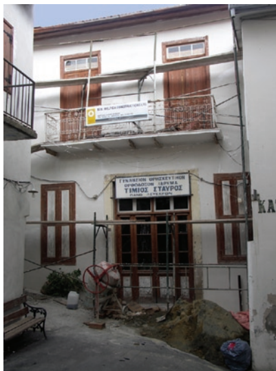
Nouvel enduit sur la façade
