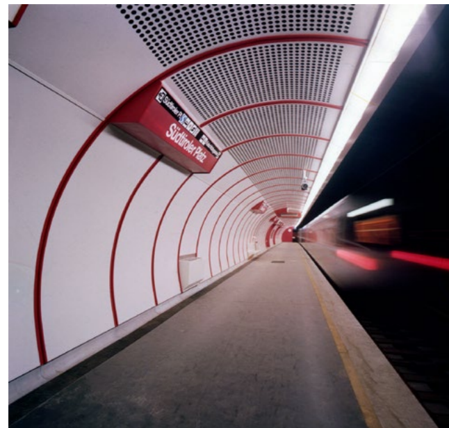
Abb. 4: Innenausbau des U-Bahnhofs Südtiroler Platz (U1), Wien. Foto, Mai 1976
