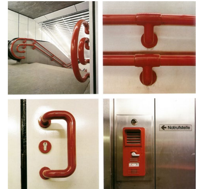
Abb. 6: Baudetails auf Bahnhöfen der U-Bahnlinie 1, Wien, Signalfarbe rot. Fotos vor 1993
