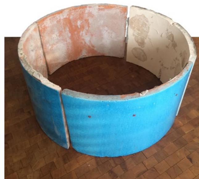
Abb. 8: Geborgene Teile der Keramikverkleidung der Stützen des U-Bahnhofs Sendlinger Tor (eröffnet 1971), München. Foto, Januar 2019
