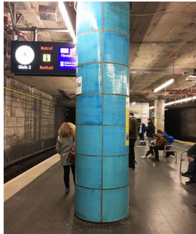
Abb. 1: Laufende Umbauarbeiten am U-Bahnhof Sendlinger Tor, München. Foto: Europa Frohwein, Februar 2019
