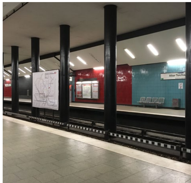
Abb. 12: Hamburg, Wandsbeker Linie, U-Bahnhof Alter Teichweg, Zustand 2018, Veränderungen nur in der Bahnsteig-Ausstattung. Foto: Sabine Kock
