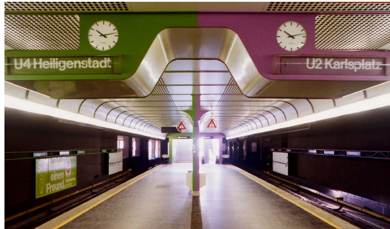
Abb. 7: U-Bahnhof Schottenring, Wien: Zwei Signalfarben auf einem Bahnsteig. Bis 2008 war der bahnsteiggleiche Übergang von der U2 (violett) in die U4 (grün) möglich. Foto vor 2008
