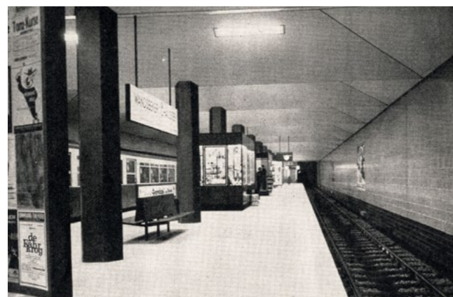
Abb. 3: Hamburg, Wandsbeker Linie, U-Bahnstation Wandsbeker Chaussee, Bahnsteigausstattung. Foto 1962
