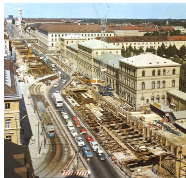
Abb. 4: Blick vom Odeonsplatz in die offene Baustelle der Nord-Süd-U-Bahnlinie U6 entlang der Ludwigstrasse, München. Foto: Alfred Haase, 1966
