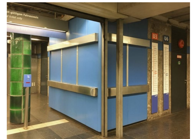
Abb. 9: U-Bahnhof Nordfriedhof (eröffnet 1971), München, mit nachträglich eingebautem Übergang, behindertengerechtem Aufzug und ausgetauschten Wandpaneelen. Foto: Yinghze Zhang, 2019
