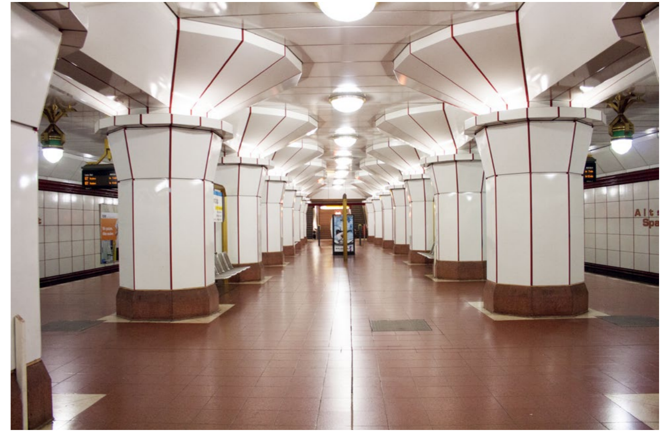
Abb. 11: Doppelstützenreihe auf dem U-Bahnsteig Altstadt Spandau, 1984. Foto 2014
