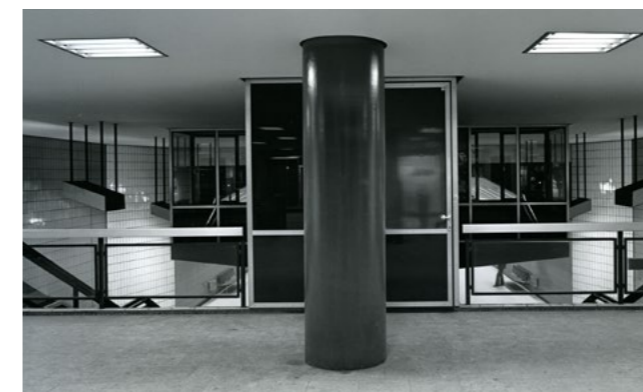
Abb. 5: Hamburg, Wandsbeker Linie, U-Bahnstation Alter Teichweg, Schalterebene im Zwischengeschoss mit Zugang zur Haltestellenwärterkanzeln. Foto: Hans Meyer-Veden, 1963
