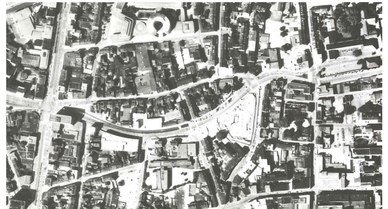
Abb. 10: Straßendurchbruch im Friesenviertel im Zuge des U-Bahnbaus, Köln. Luftbilder 1957/1987
