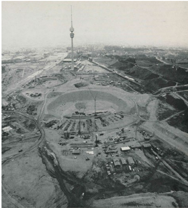
Abb. 1: Olympiagelände München, Baustelle, Luftbild um 1970
