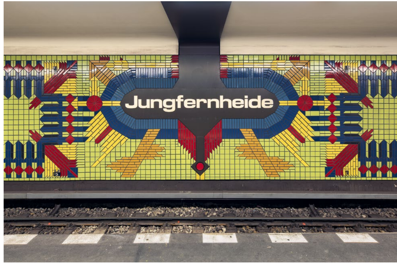
Abb. 8: Mosaik an der Hintergleiswand des U-Bahnhofs Jungfernheide, 1980. Foto 2018
