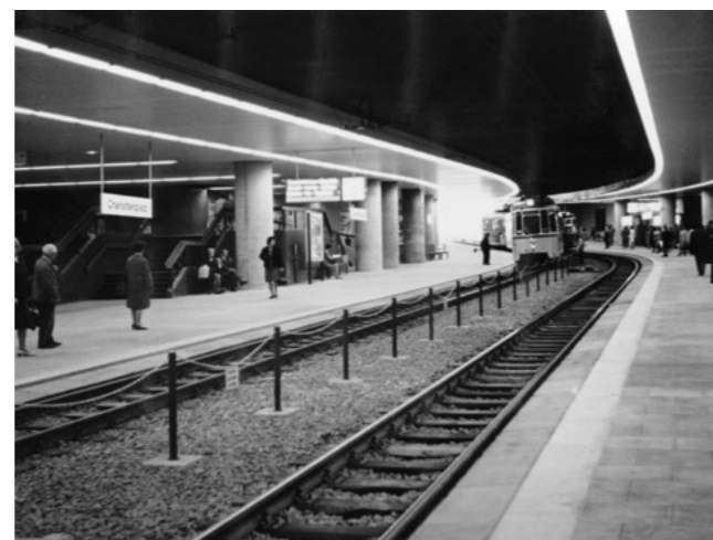
Abb. 7: Der neue Charlottenplatz unter Straßenniveau. Einfall von Tageslicht am Bahnsteigende, dynamische Schienen- und Lichtbandführung. Foto um 1967
