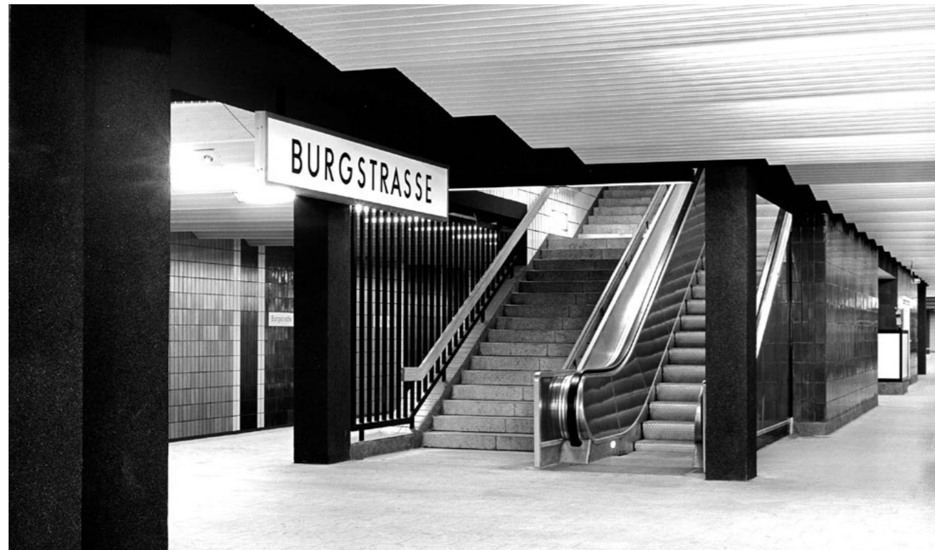
Abb. 2: Hamburg, Neubaulinie Billstedt, U-Bahnstation Burgstraße, Gestaltung Tunnel, Bahnsteig und Aufgang. Foto 1967
