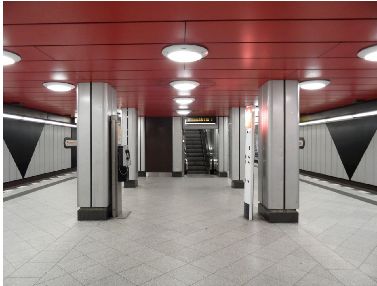
Abb. 1: Der U-Bahnhof Bismarckstraße aus den späten 1970ern ist seit 2016 entkernt und wird in Vorkriegs-Anmutung neugestaltet. Foto: Magnus Manske, 2011
