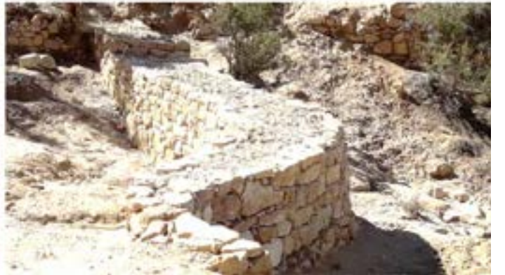
Dam 6 After re-construction السد 6 بعد إعادة البناء
