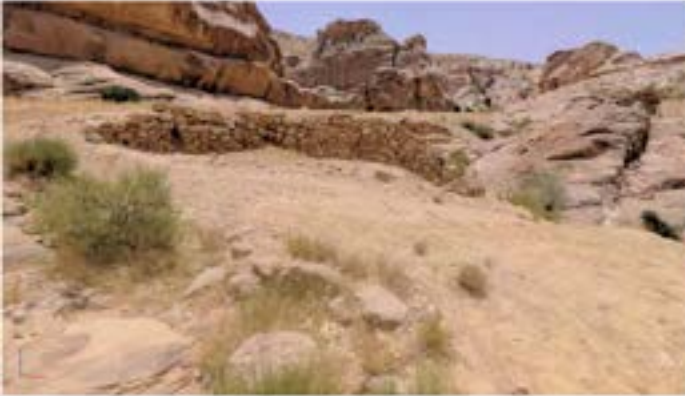
Dam 4 Before re-construction السد 4 قبل إعادة البناء
