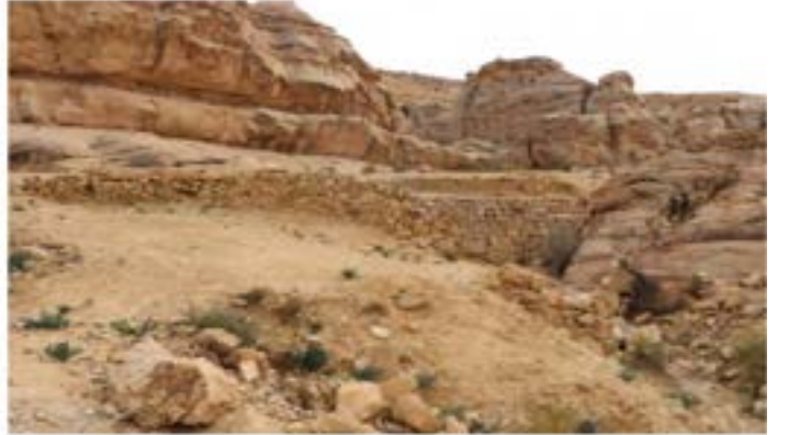
Dam 4 After re-construction السد 4 بعد إعادة البناء
