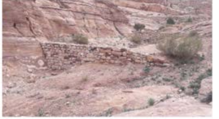
Dam 2 After re-construction السد 2 بعد إعادة البناء
