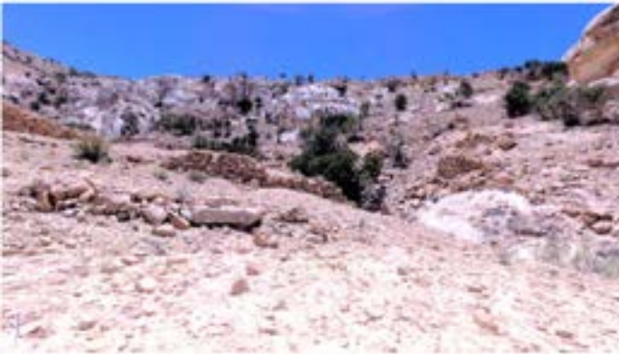
Dam 6 Before re-construction السد 6 قبل إعادة البناء
