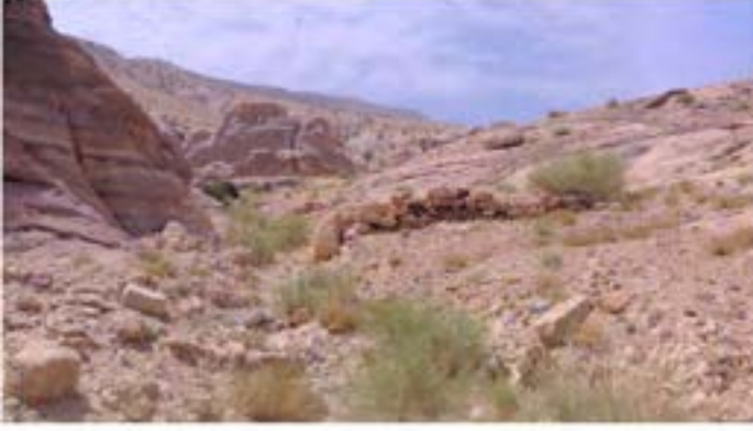
Dam 2 Before re-construction السد 2 قبل إعادة البناء
