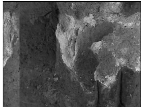
Fig. 6. La pátina aceitosa ennegrecida fue anterior a las lesiones (vesiculación, arenización y exfoliación) y causante parcial de las mismas, junto con la presencia de cloruros bajo la misma.
