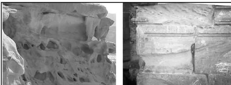
Fig1. Encostramiento de la piedra arenisca con cemento carbonatado. A la izquierda, efectos de la erosión eólica en afloramientos de esta piedra en el desierto del Wadi Rum en Jordania, a la derecha encostramiento en la piedra de la Catedral de Tarazona.
