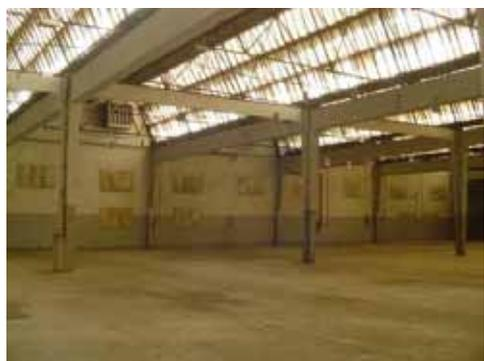
**Fig. 95 G:** CMSP, estrutura em concreto, sistema de cobertura em *shed*, alguns vão de janelas fechados. Foto: Autor, 2008.
