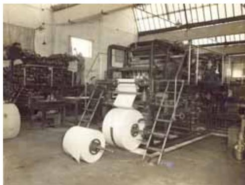
**Fig. 91 E:** CMSP, impressão máquina rotativa, 1942. Fonte: Acervo da empresa.
