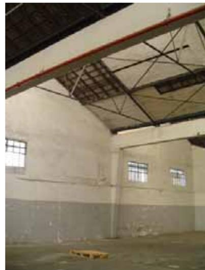
**Fig. 95 B:** CMSP, vista interna. Sistema de cobertura e partes de forro remanescente.
