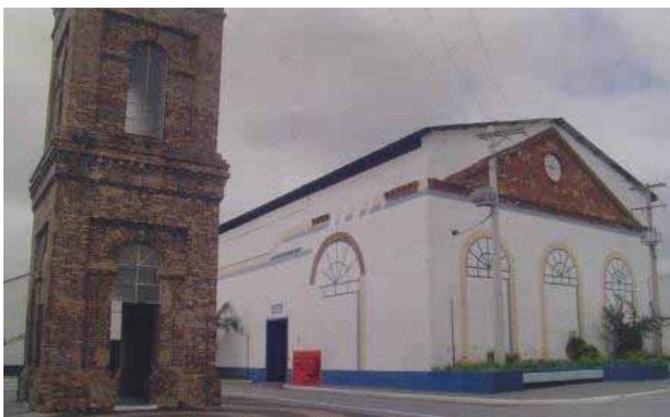
**Fig. 98 A:** Edifício Amazonas, 2009. Parte de arcos e cornija em alvenaria conservados. Fonte: SÃO PAULO (cidade), SMC/CONPRESP, Res. 05/09, p.386.
