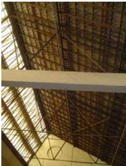
**Fig. 95 A:** CMSP, vista interna. Sistema de cobertura em *shed*, telhas em cimento amianto (não são mais as telhas cerâmicas originais).
