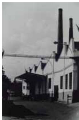
**Fig. 87 E:** Vestígios de elementos arquitetônicos originais: cobertura em *shed* e detalhes na fachada. Fonte: SÃO PAULO (cidade), SMC/CONPRESP, Res. 39/92, p. 164.
