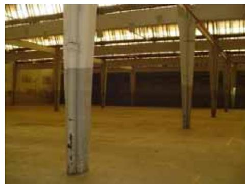
**Fig. 95 H:** CMSP, estrutura em concreto, sistema de cobertura em *shed*, alguns vão de janelas fechados. Foto: Autor, 2008.
