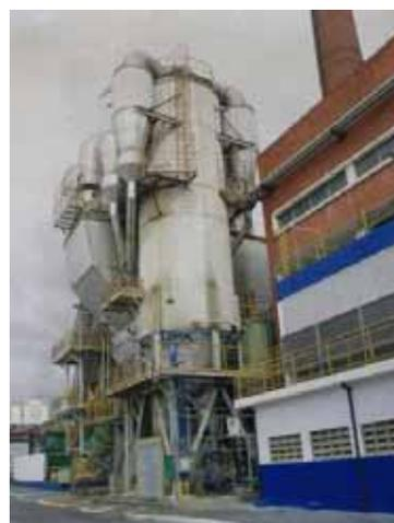
**Fig. 100 I:** Eletrofiltro junto à chaminé N. 20.
