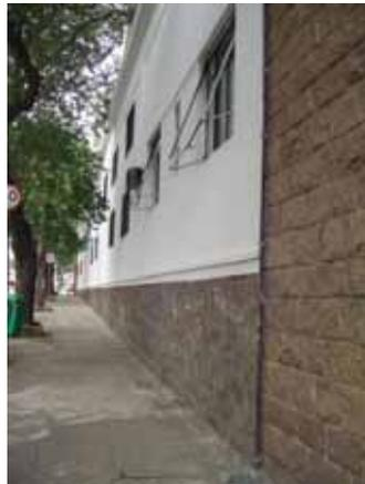
**Fig. 96 B:** CMSP, detalhe embasamento de pedra da fachada. Foto: Autor, 2008.
