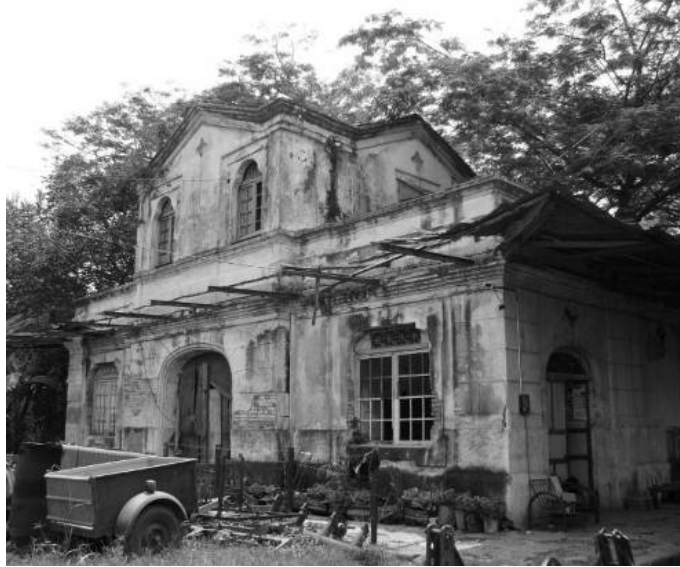
Fig. 1 La estación ferrocarril de Picaleña en Ibagué (2010)
