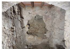
Dettaglio del riempimento posto sotto il solaio dell'ex archivio
