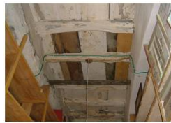
Particolare del soffitto caratterizzato da una struttura in legno con orditura principale e secondari e tavoli. Evidenti gli interventi eseguiti in tempi imprecisati e con metodi e materiali provvisori.
