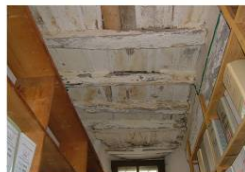
Particolare del soffitto caratterizzato da una struttura in legno con orditura principale e secondari e tavoli. Evidenti gli interventi eseguiti in tempi imprecisati e con metodi e materiali provvisori.
