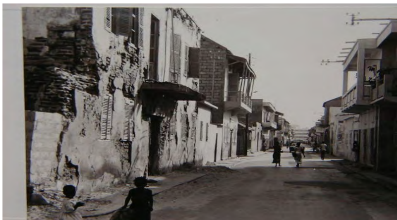
Photographie 3 : Bâtiments très dégradés
