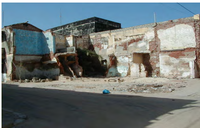
Photographie 5 : Démolition achevée deux ans plus tard (même maison)
