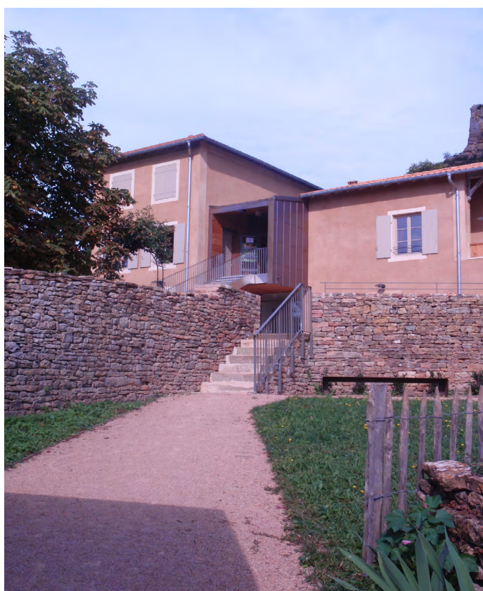
8 – Accès au bâtiment d'accueil
