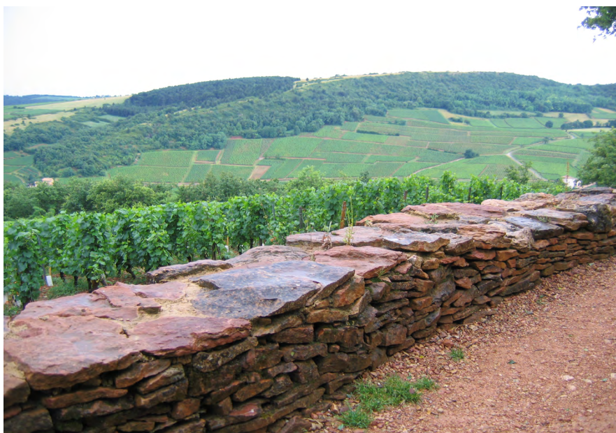
6 – Un des murets de pierres sèches construits pour border les cheminements
