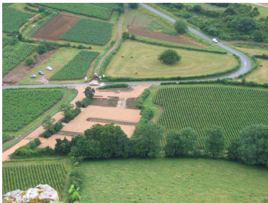
3 – Le parc de stationnement en cours d'aménagement en 2008
