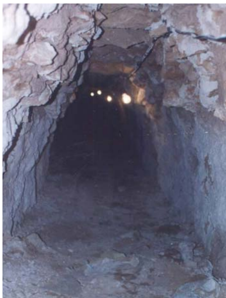
Canal souterrain lors des travaux de restauraton
