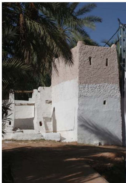
Puit d'irrigation et capteur d'eau de crue
