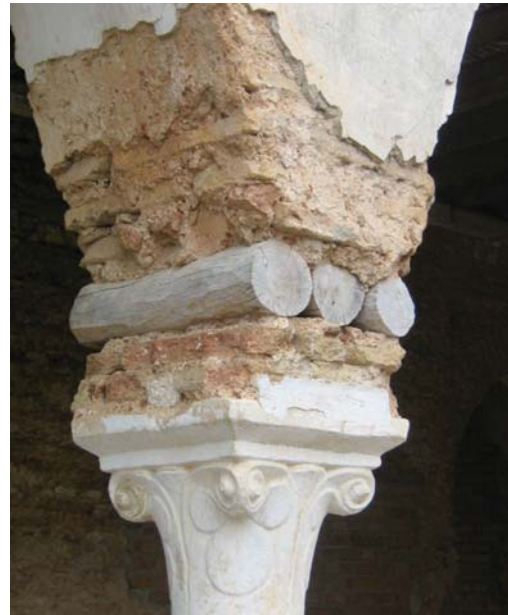
Détail articulation colonne - arc
