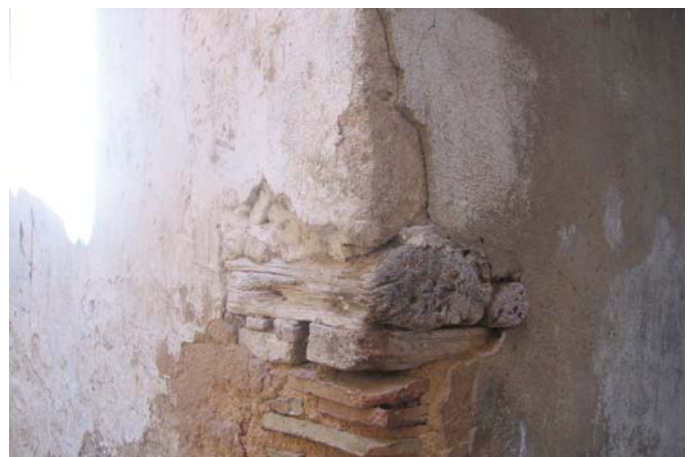
Bois inséré dans la maçonnerie à Fès
