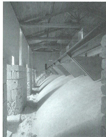
Nouveau plancher posé sur la voûte du xvii e siècle. Photo: P. Ruault, 1999.
