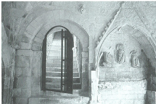
Niveau cloître, nouvelle porte d'accès à l'escalier du dortoir. Photo: N. Detry, 1999.
