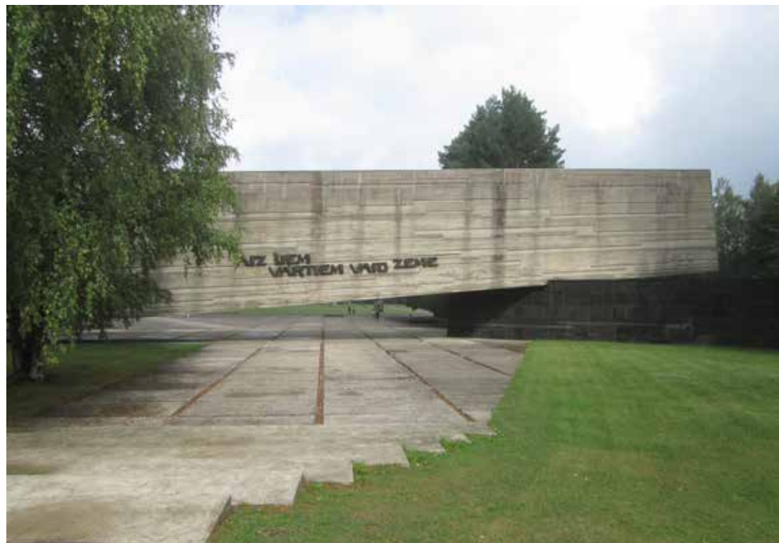
Vides plānošanas radošie risinājumi var novest līdz dziļākām simbiotiskām attiecībām. Salaspils memoriāls, kas 60. gados tapa Otrā pasaules kara nacistu koncentrācijas nometnes jeb policijas cietuma vietā, ir gan piemiņas vieta, gan arhitektūras un tēlniecības sintēzes mākslas darbs. Foto: Jānis Lejnīks
