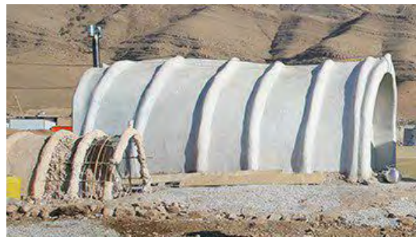
تصویر ۱۴- ماکت کوچک نشان‌دهنده مراحل مختلف ساخت کومه‌ها برای توضیح و آموزش بهتر به روستاییان منبع: نگارنده.
