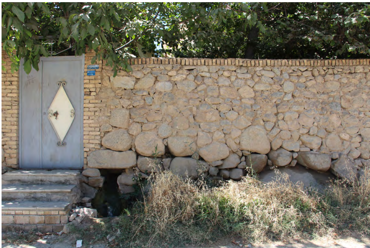
تصویر ۱۱. دیوار سنگ چین با ملات گل و ترکیب با آجر. به نظر میرسد سنگ های پایین کار در مجاورت معبر آب هست و به صورت خشکه چین کار شده است. روستای بنادک سادات. مرداد ۱۳۹۸.
