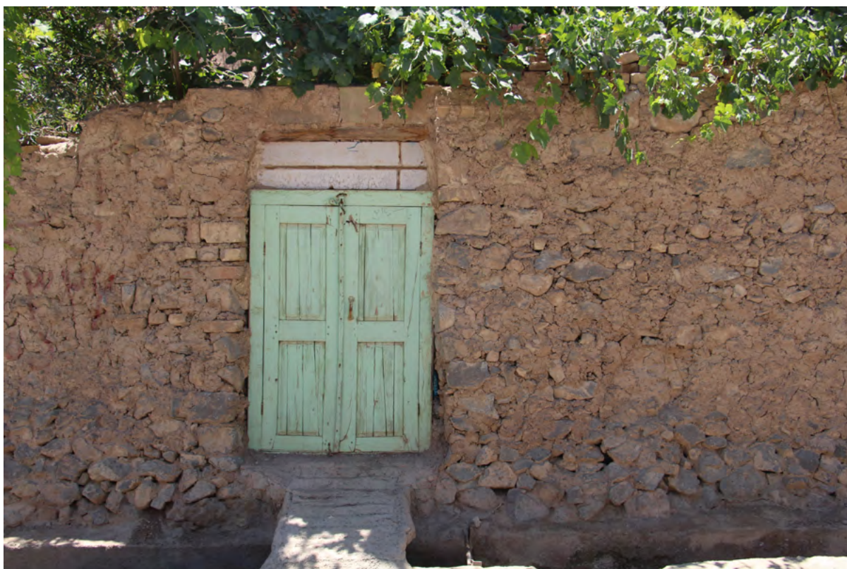
تصویر ۱۵. استفاده از سنگ و آجر در ترکیب با گل چینه برای اجرای دیوار. روستای هنزا. مرداد ۱۳۹۸.
