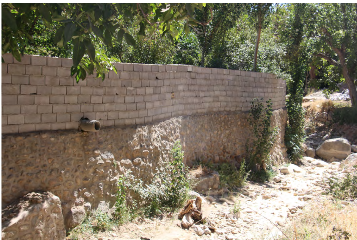
تصویر ۳۱. دیوار سنگ چین معبر رودخانه با ملات ماسه سیمان و اجرای حصار باغ مجاور با بلوک سیمانی. روستای بنادک سادات، مرداد ۱۳۹۸
