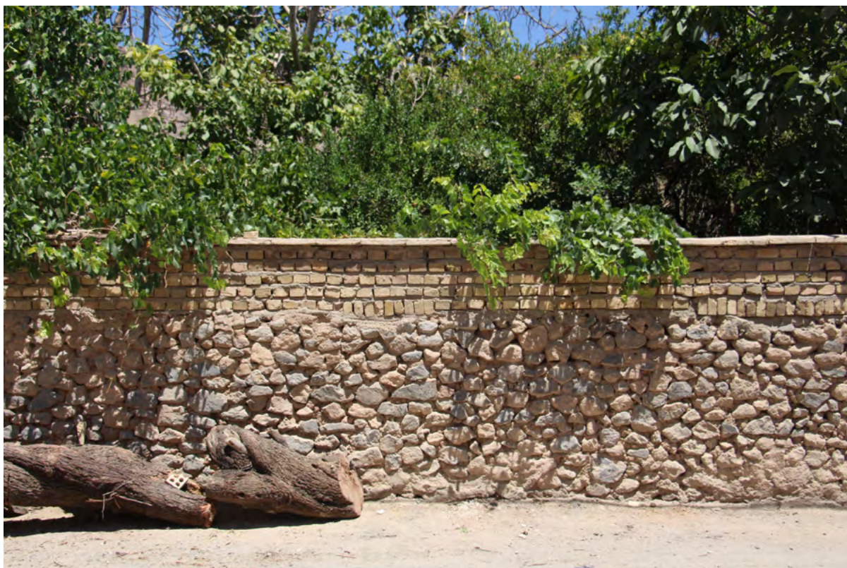
تصویر ۱۴. دیوار سنگ چین در ترکیب با آجر و آبچکان سنگی. مهریز، روستای هنزا. مرداد ۱۳۹۸
