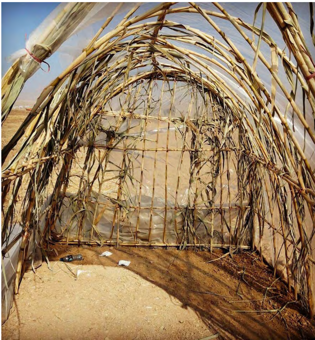
تصویر ۳- کپر ساخته شده توسط مردم بومی منطقه با استفاده از گیاه نی و پوشش آن با نایلون منبع: نگارنده.
