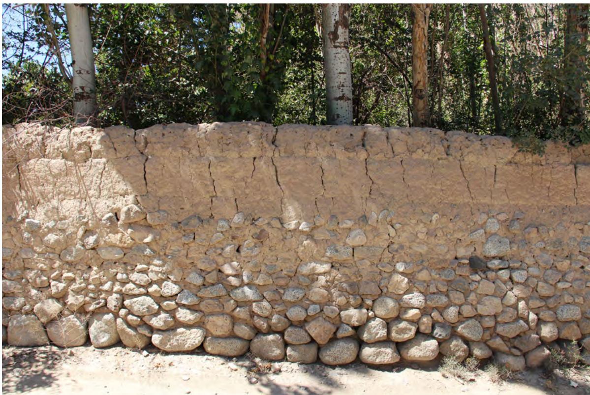
تصویر ۹. اجرای حصار با ترکیب دیوار سنگ چین و دیوار چین، روستای بنادک سادات. مرداد ۱۳۹۸.
