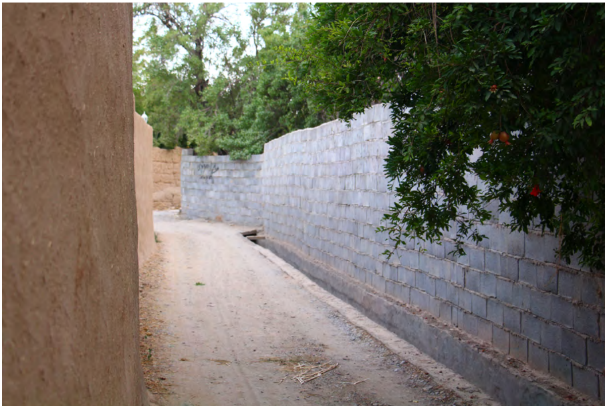
تصویر ۲۴. تعریض کوچه باغ‌ها و به کارگیری بلوک‌های سیمانی برای جداره باغ‌ها. مهریز، محله مزویرآباد، مرداد ۱۳۹۸.
