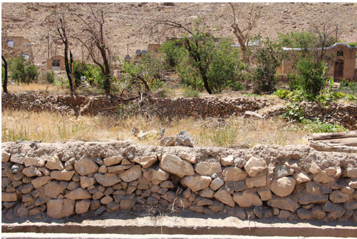
تصویر ۱۸. دیوارهای سنگ چین برای تعیین حدود اراضی کشاورزی و تسطیح و استحکام بخشی اراضی در شیب تند. روستای هنزا، مرداد ۱۳۹۸.
