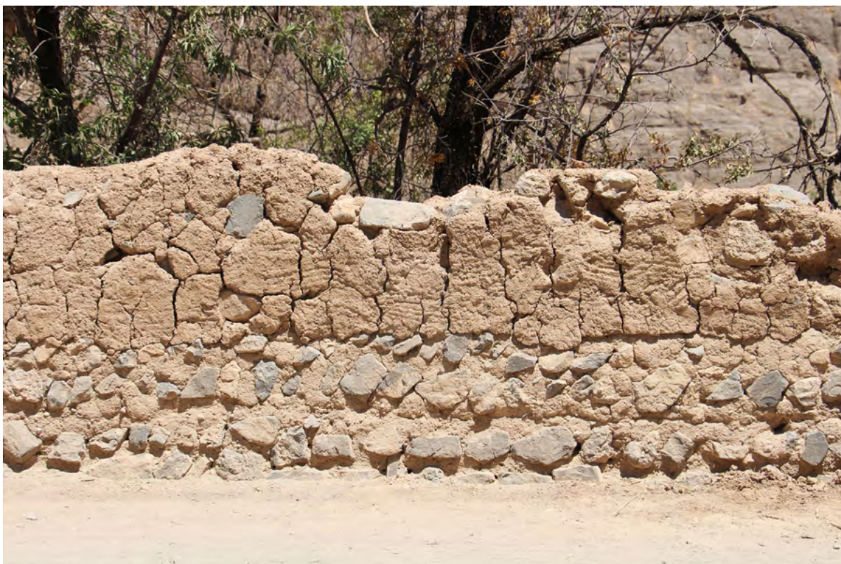
تصویر ۸. اجرای حصار با ترکیب سنگ و دیوار چین، روستای بنادک سادات. مرداد ۱۳۹۸.
