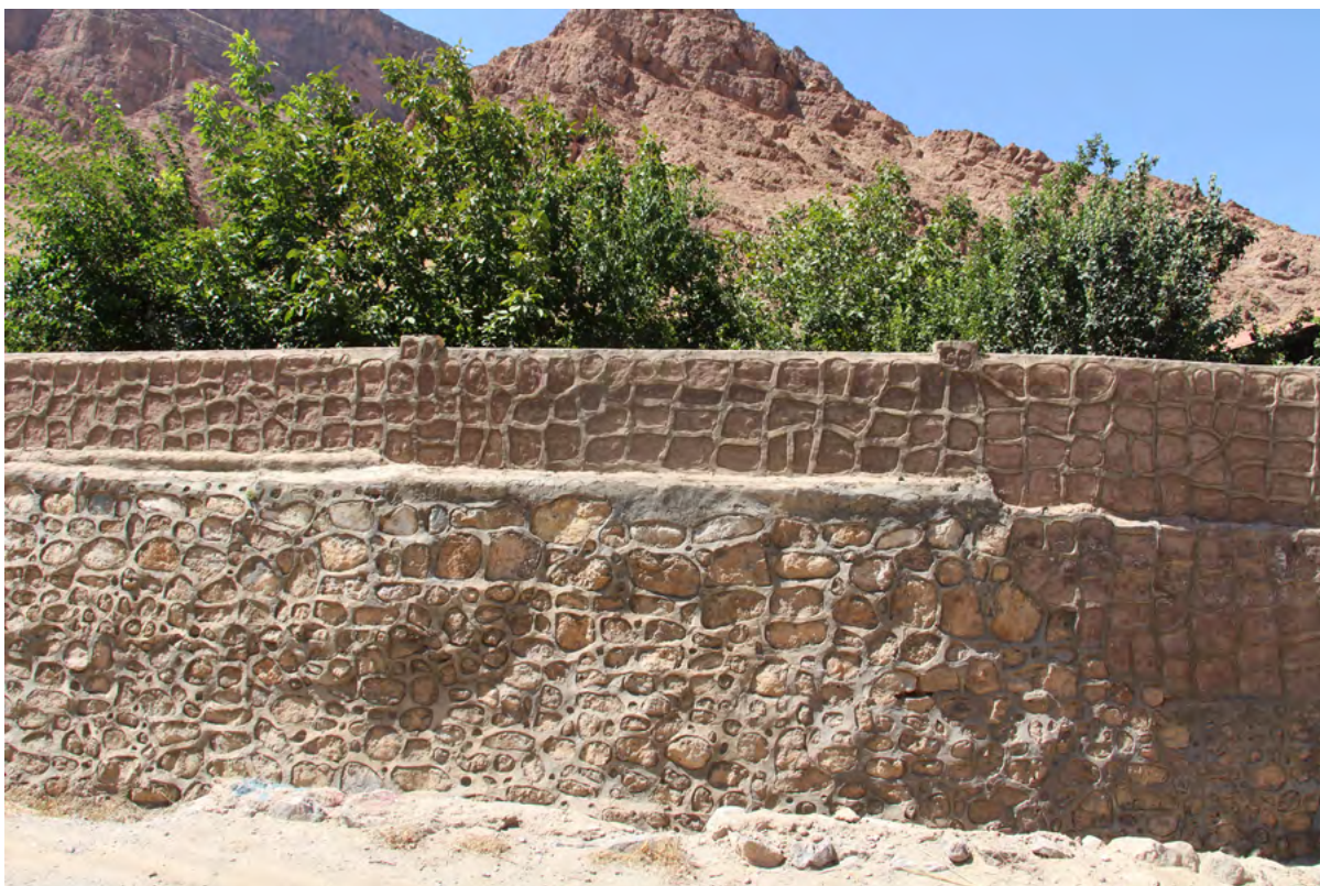
تصویر ۳۲. ساماندهی جداره‌ی رودخانه با دیوار سنگ چین با ملات و بندکشی سیمانی. روستای فخرآباد. مرداد ۱۳۹۸.
