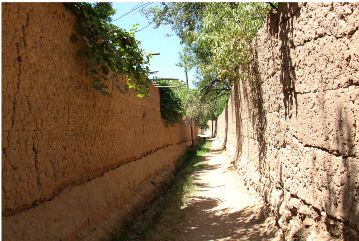
تصویر ۲. استفاده از دیوارهای چین به عنوان حصار و جداره باغها. شیوه سنتی و اصیل، معبر آب در امتداد کوچه و پای دیوار دیده می‌شود. مهریز محله مزویرآباد. مرداد ۱۳۹۷.
