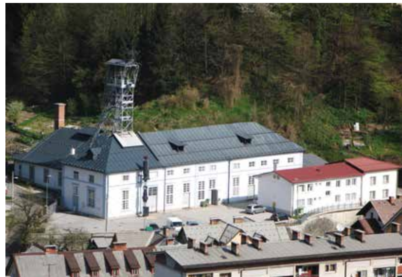
Idrija, vhodna stavba v rudnik (foto: Ministrstvo za kulturo Republike Slovenije, Indok center) Idrija, main mine building (photo: Ministry of Culture of the Republic of Slovenia, Indok Centre)
