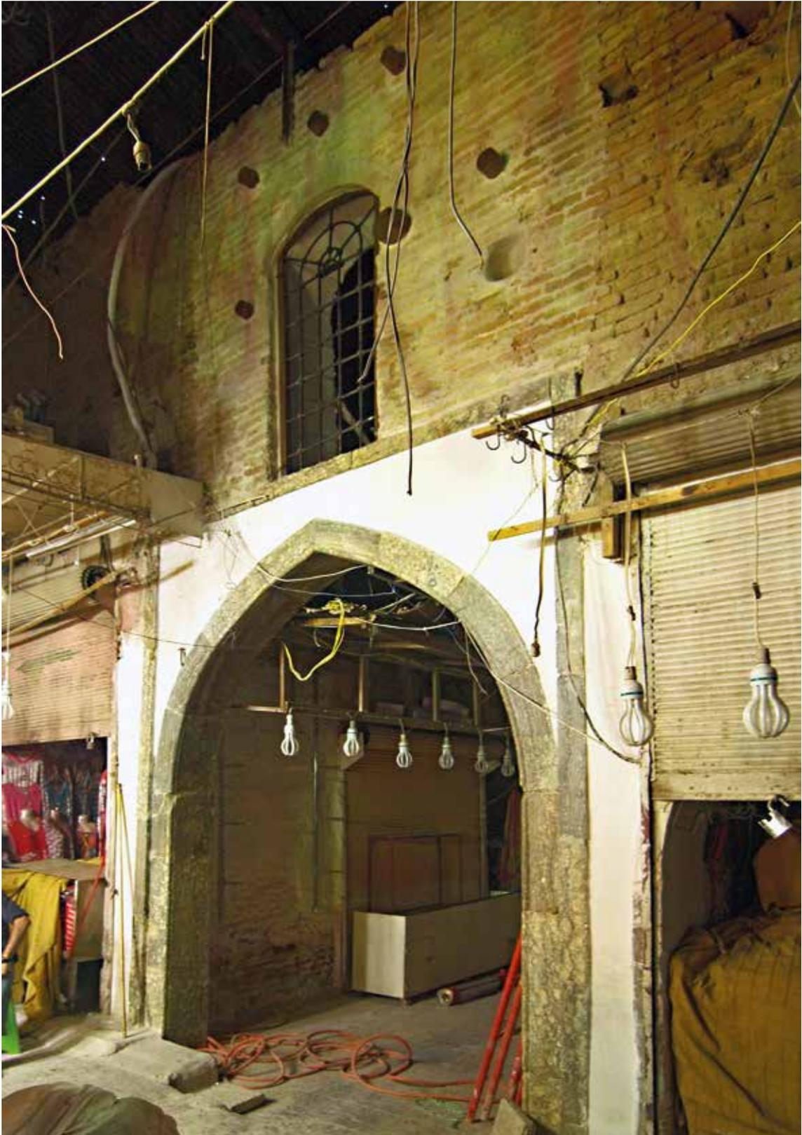
7 Erbil, Nord-Irak. Konservierte Fassaden-Musterflächen an der westlichen Qaisariya im Basar mit gereinigten und versiegelten Natursteinbauteilen, ergänzt und neu verfugtem Ziegelmauerwerk sowie einem rekonstruierten schmiedeeisernen Fenstergitter im Obergeschoss. Foto: Dietmar Kurapkat, DAI Berlin.
