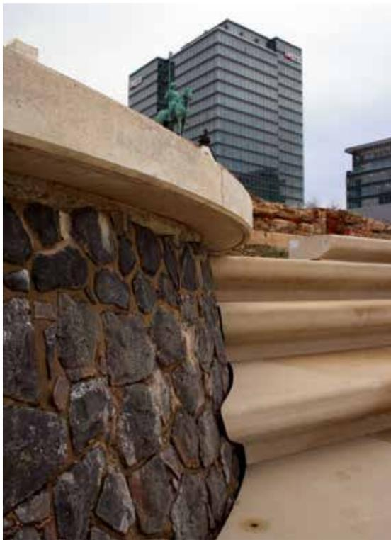
6 Ausgrabungen am Rheinboulevard in Köln-Deutz: Der Nordwestturm des spätantiken Kastells, der im 19. Jahrhundert mit einer Basaltlage neu verkleidet wurde, ist in die moderne Freitreppe integriert.
