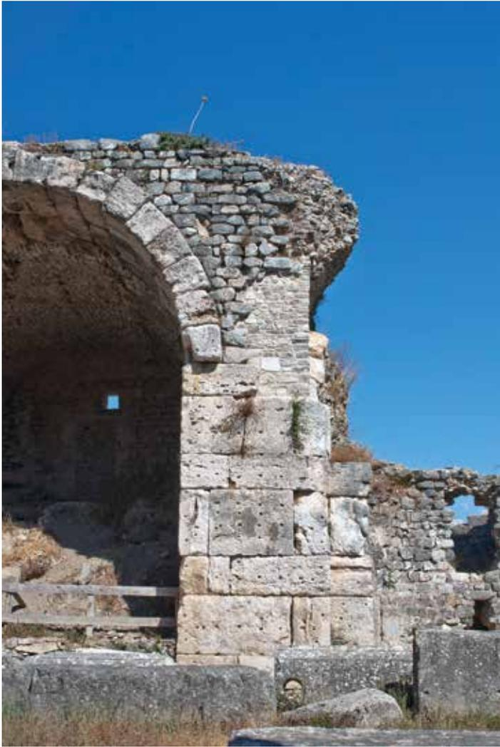
18 Milet, Faustinathermen, Sicherung eines Gewölbefängers mit einer kleinteiligen, rückversetzten Mauerwerksplombe von 2013. Foto: D. Göcmen, DAI Istanbul.
