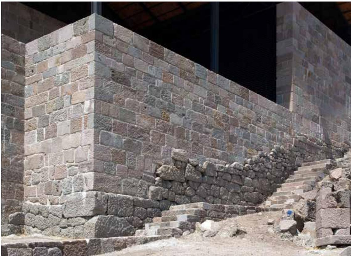
10 Pergamon, Bau Z, Differenzierung zwischen dem originalen Mauerbestand und den ergänzten Partien, darüber die Zäsur zum Dach mit den Stahllamellen. Foto: A. Schwarting, DAI Pergamongrabung.
