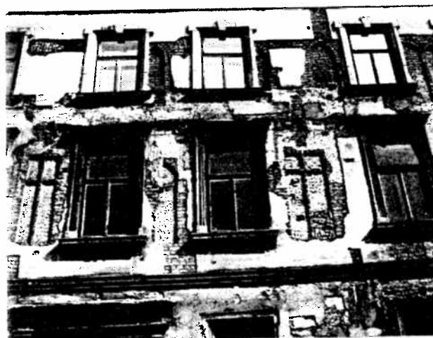
Un fragment de la façade d'une maison rue Kanonicza. L'effet des recherches de conservation. Une décoration architectonique gothique mise au jour qui avait été recouverte ensuite par une peinture de la Renaissance.
