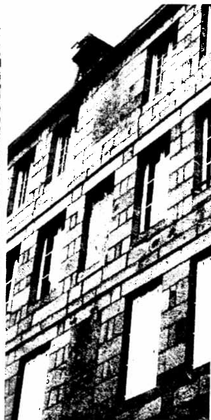
6 - Façade de granit et blocage.
