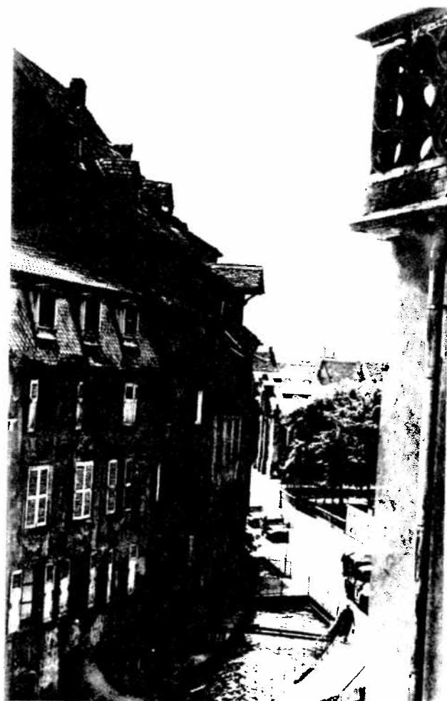
Vue de la rue des Tanneurs avant restauration.
