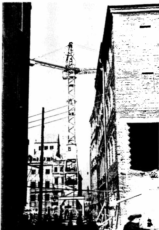
Varsovie, Vieille Ville, la place du marché pendant les travaux de la reconstruction.
