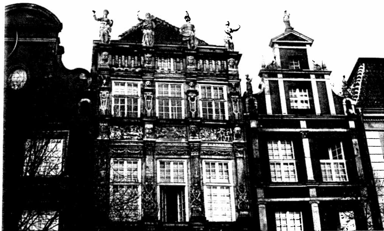
Gdańsk. Reconstruction exacte d'une vieille maison voisinant avec une façade simplifiée (Photo I. Maheu).
