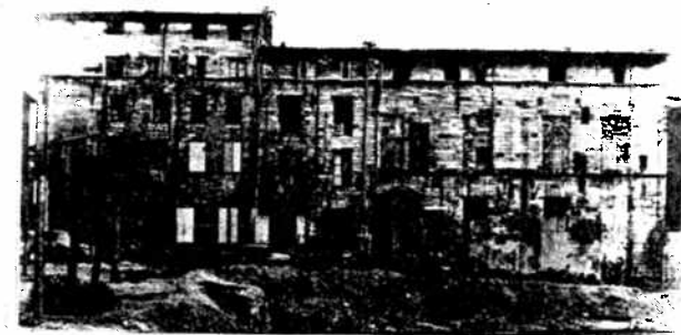
Ilot P avant démolition, rue St-Etienne.
