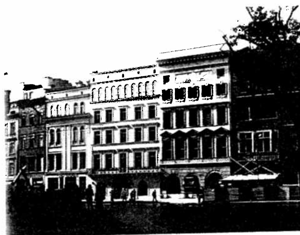
Les façades des maisons de la Place du Marché après les travaux de restauration (1980).
