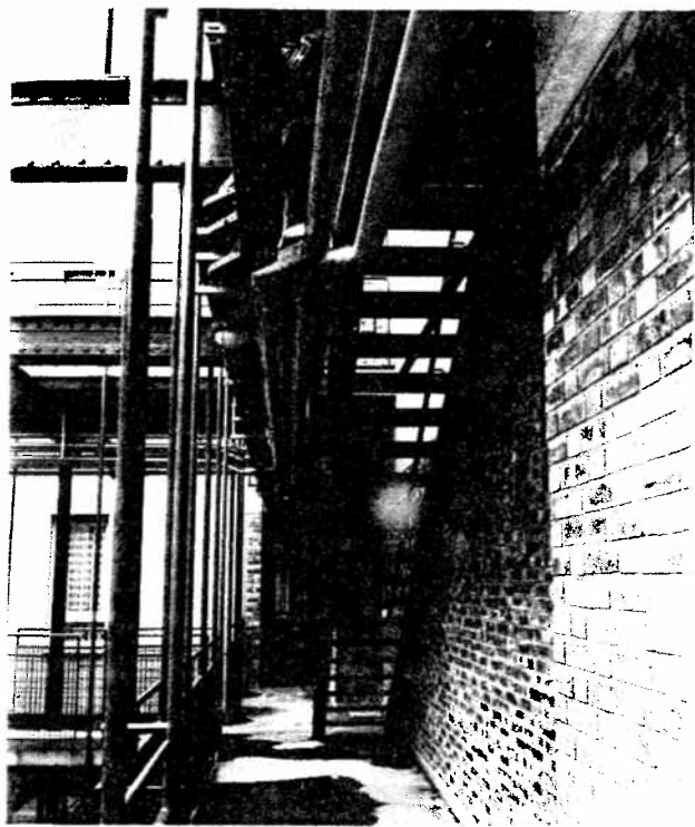
Couloir au 1 er étage (Photo L. Maheu).
