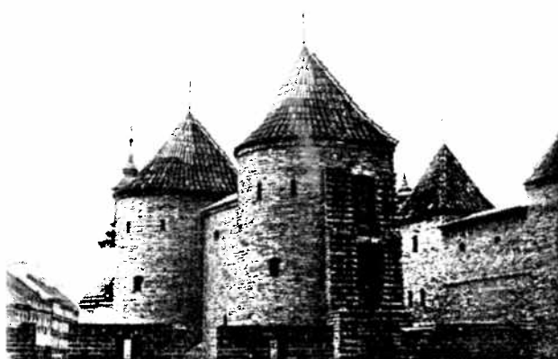
La barbacane de la Vieille Ville après les travaux de conservation (côté du centre de la vieille ville).
