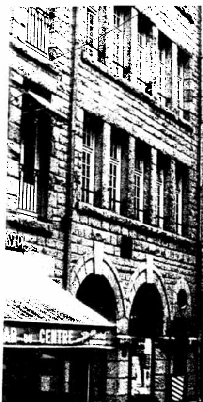
5 - Façade de moellons éclatés.
