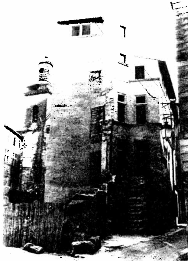
Immeuble, 1, rue Saint-Etienne, travaux en voie d'achèvement.
