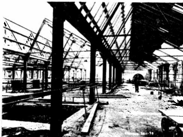
Structure métallique de l'entrepôt.
