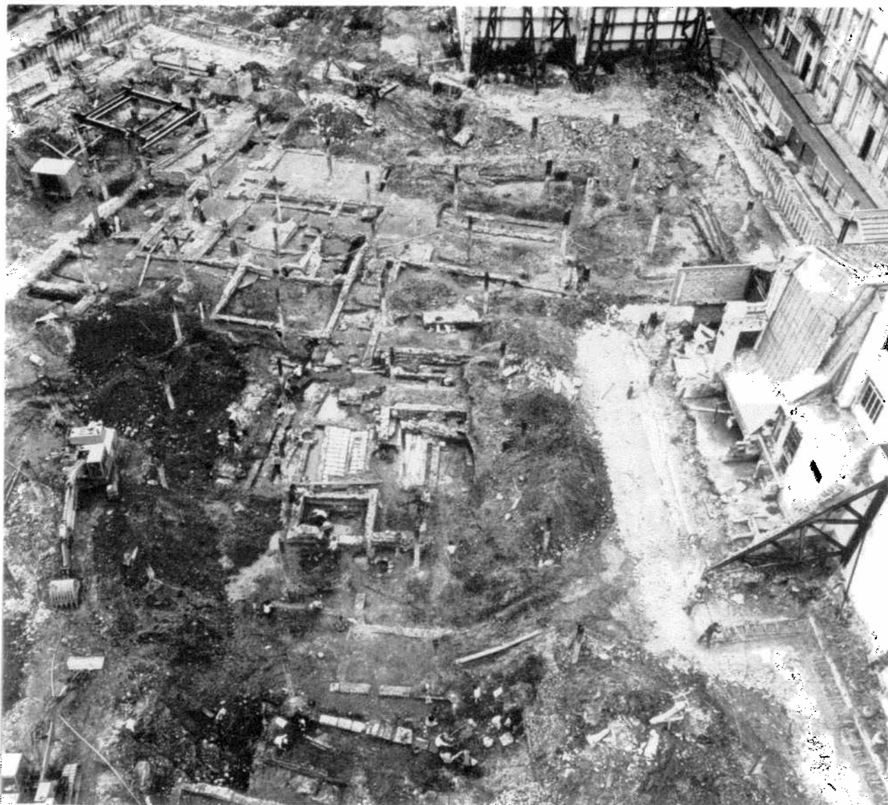
BORDEAUX, ST-CHRISTOLY, vue d'ensemble du chantier — 1982 — cliché D.A.H.A.
