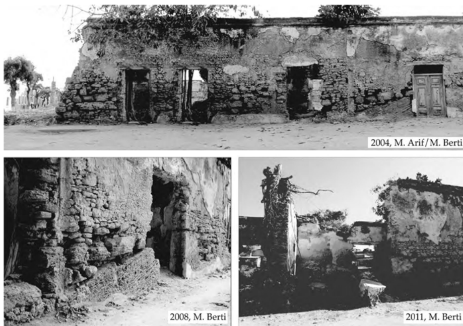
Fig.3. Coral stonewall at the Praça dos Heróis in Ilha de Moçambique. In 2004, 2008 and 2011.
