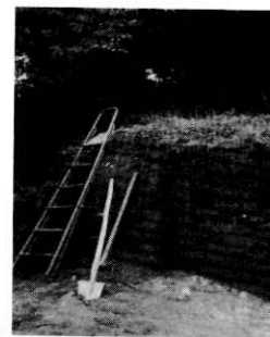
a Fig. 9 Bastione Santa Croce
