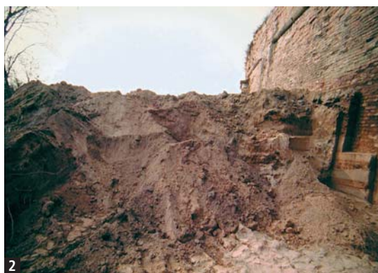
Figura 2 I primi scavi per valutare le caratteristiche del terreno golenale nel 1986.
