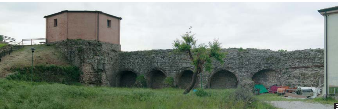
Figura 3 Torre del Portello vecchio. Si ipotizza che i cinque forni che si dipartono dal torrione siano stati gli archi attraverso i quali passava l'acqua del fossato interno del Castelnuovo. Probabilmente, nella condizione primitiva di questo bastione (completamente intercluso e isolato) su questi stessi archi era impostata la via di accesso al bastione.
