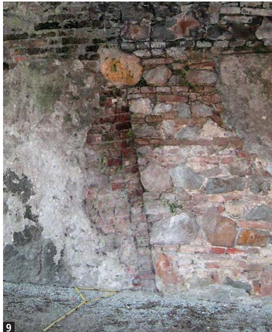
Figura 9 Ancora leggibilissima la sezione della cortina della città che costituiva la controscarpa del fossato del Castelnuovo. Interessante l'angolazione tenuta da questo frammento di cortina rispetto a quella dirimetto del castello.
