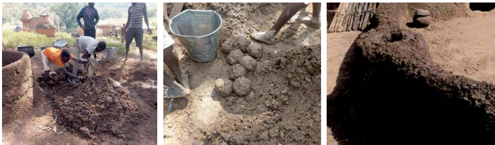
Malaxage de la terre destinée à l'élévation des murs
