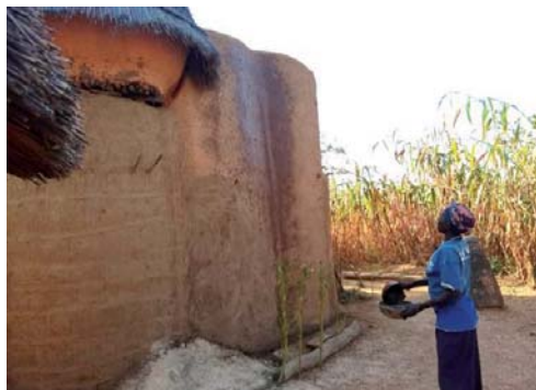
Projection du badigeon sur les parois avec une petite calebasse
