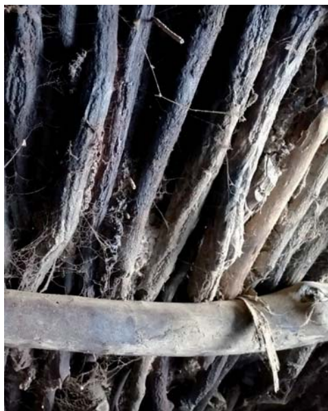
Poutre supportant des poutrelles
