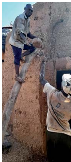
Remplissage de la partie à colmater
