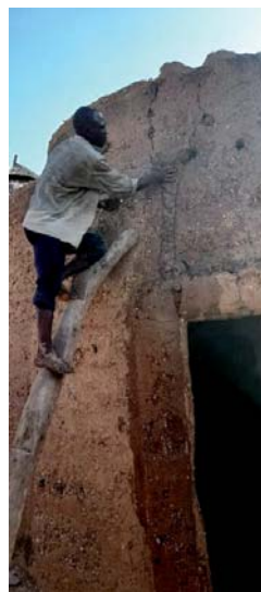
Remplissage de la partie à colmater
