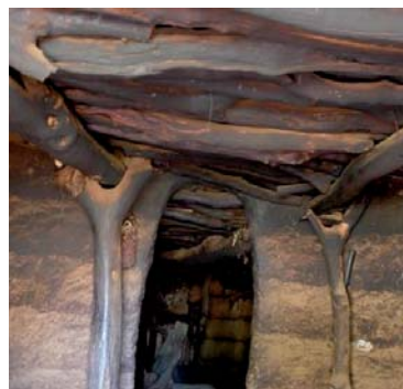
Vue de l'intérieur de 2 poteaux fourches supportant 2 poutres qui elles-mêmes supportent des poutrelles
