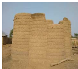
Tourelles et murs terminés
