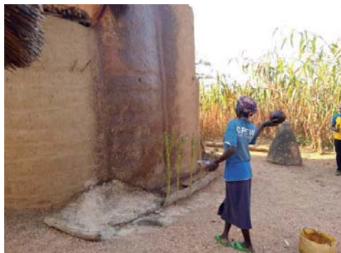
Projection du badigeon sur les parois avec une petite calebasse
