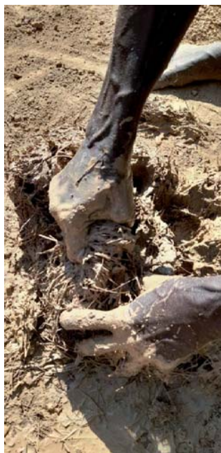
Malaxage des fibres avec la barbotine
