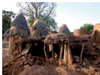
Usure de la toiture-terrasse
