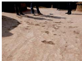
Usure de la toiture-terrasse
