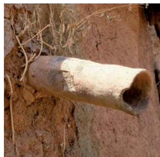
Gargouille endommagée
