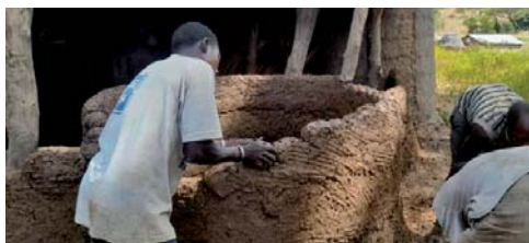
Façonnage de la quatrième assise
