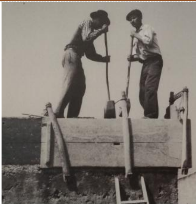
Banche traditionnelle utilisée par Aldeia da Luz à avant 1950. [Source: Museu da Luz, Luz, Évora, 2018]
