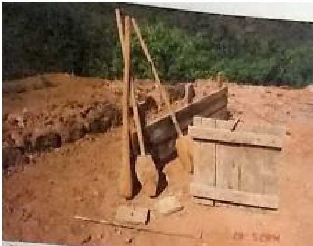
Banche traditionnelle, boulon, entretoise, et outils [Source: Lobo, Earth in Architecture , p.44]
