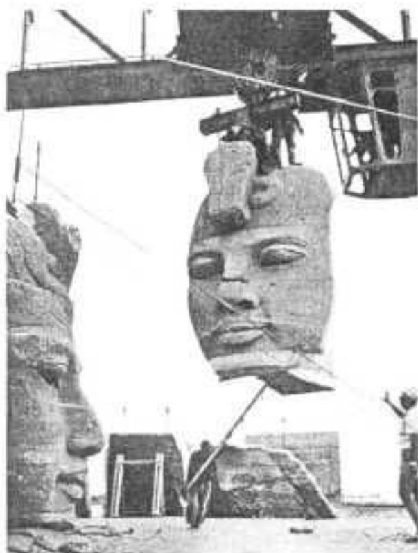
O templo de Ramesses II, um dos de Abu-Simbel, antes do enchimento do lago Nasser (em cima), e uma fase da transferência dos blocos cortados antes do enchimento da albufeira (em baixo).
