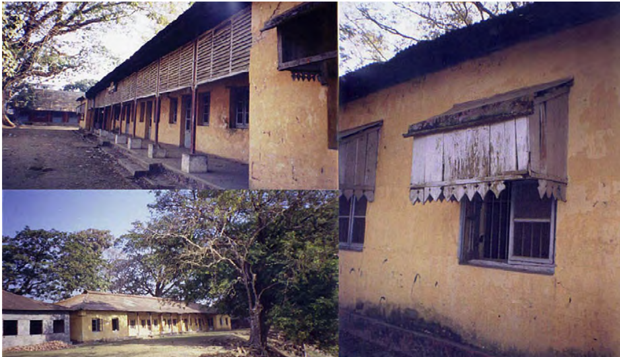
تصویر شماره ۶: تکنیک‌های سایه‌اندازی به جهت ممانعت از ورود نور خورشید به داخل ساختمان.
