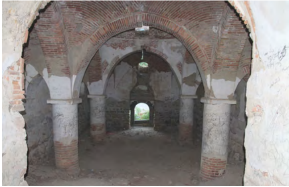
تصویر شماره ۱۶: نمای داخلی کلیسای آخته خانه. توجه شود به شباهت ستون‌ها و طاق‌ها با بنای مسجد تاریخانه دامغان و یا ستون‌های دوره سلجوقی مسجد جامع اصفهان. منبع: بوریانی.
