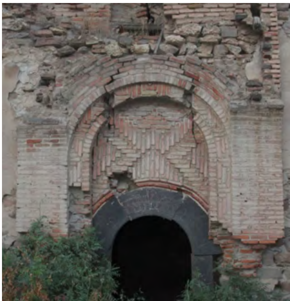
تصویر شماره ۱۸: کلیسای آخته خانه. توجه شود به نحوه اجرچینی سر در بنا. منبع: بوریانی.
