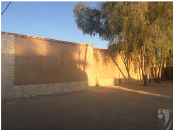
تصویر شماره ۴: اتمام عملیات مرمت دیوار.
