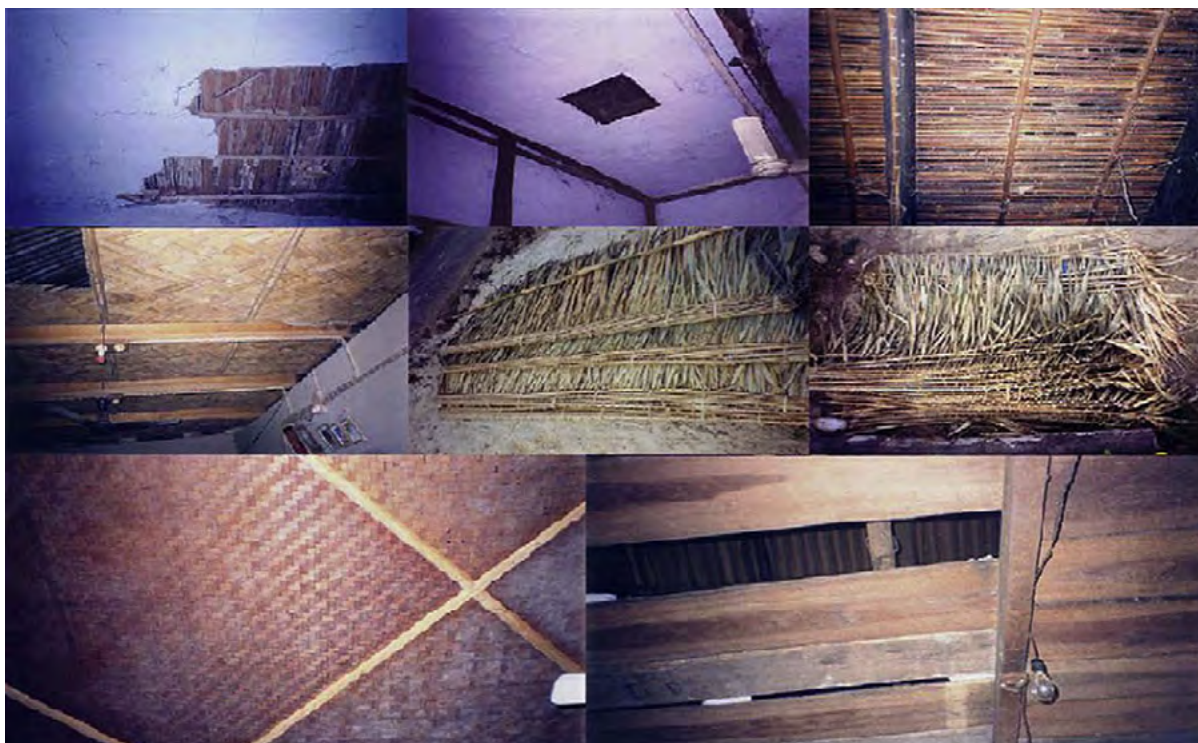
تصویر شماره ۵: مواد و مصالح و تکنیک‌های ساخت سقف کاذب.
