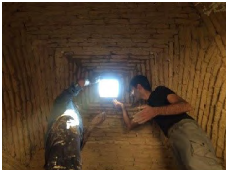
تصاویر شماره ۴۲ و ۴۳: تکمیل بخش میانی طاق و پوشش کاهگل توسط اهالی.
