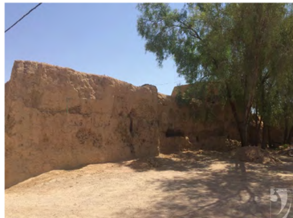
تصویر شماره ۳: آغاز عملیات مرمت در نوبندگان، سه راه عشق.
