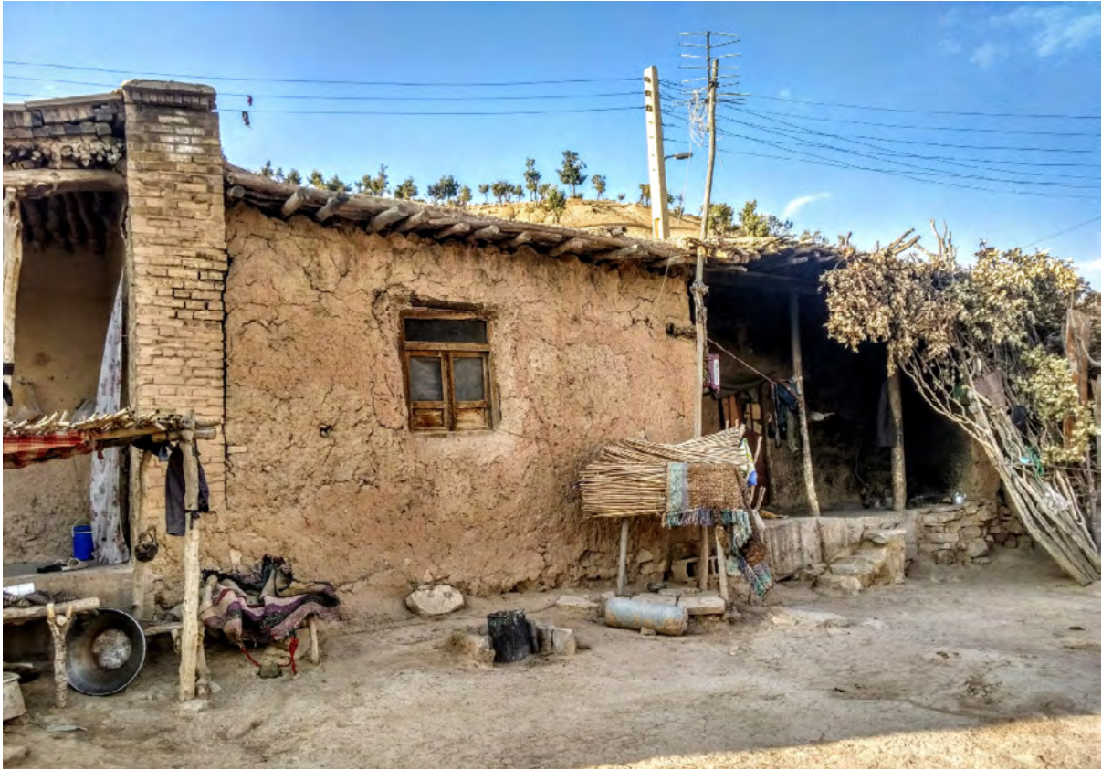
تصویر شماره ۱۰: دو خانه به هم چسبیده و حیاط مشترک که سقف خانه پایینی است.
