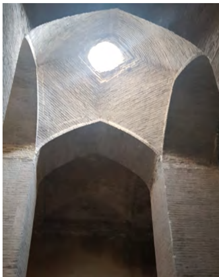
تصویر شماره ۱۳: تاق و دریچه بازدید مخزن.
