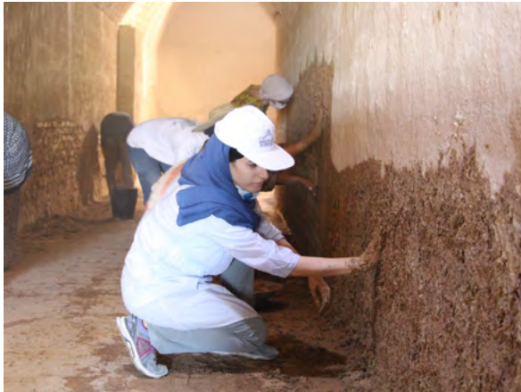
تصویر شماره ۵: ترمیم پوشش بخش تخریب‌شده دیوارها.
