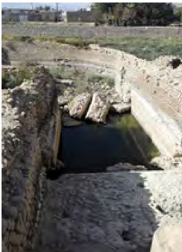
تصویر شماره ۱۷: مسیر کانال گاوشیر. مأخذ: غزاله رفعت‌ماه، بازدید آبان ۱۳۹۸.
