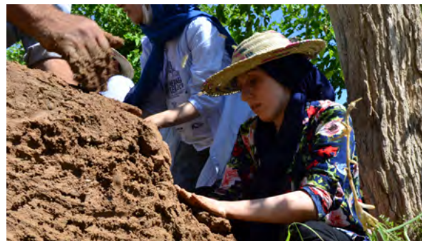
تصویر شماره ۸: آشنایی با روش چینه در معماری ایرانی، ساخت بخشی از دیوار باغات اطراف با استفاده از این روش و زیر نظر استادکار محلی.
