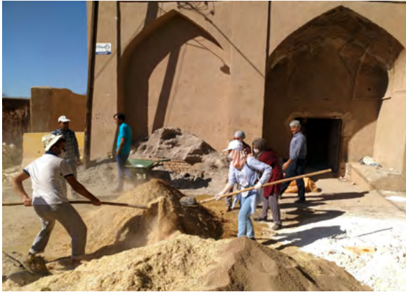
تصویر شماره ۲: آماده‌سازی کاهگل به منظور مرمت پوششی دیوارهای آسیاب آبی، آشنایی داوطلبان با تکنیک‌های ساخت در معماری بومی.
