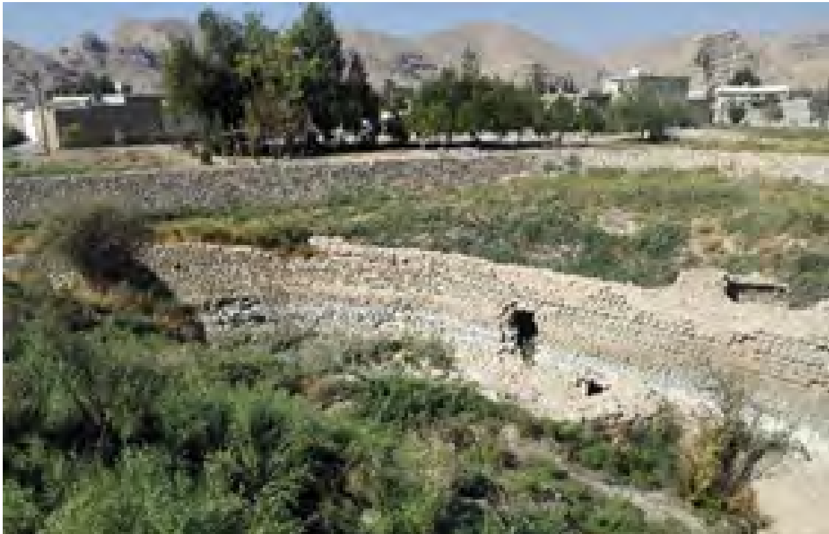
تصویر شماره ۱۸: مسیر کانال گاوشیر، مأخذ: غزاله رفعت‌ماه، بازدید آبان ۱۳۹۸.
