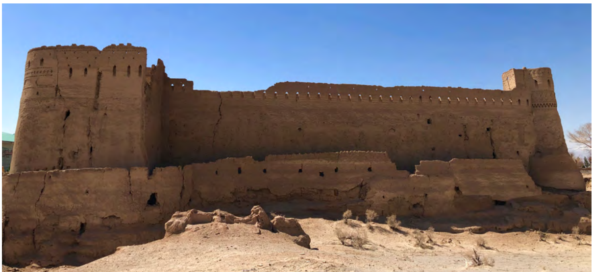
تصویر شماره ۱۷: جبهه غربی قلعه، اسفند ۱۳۹۷.
