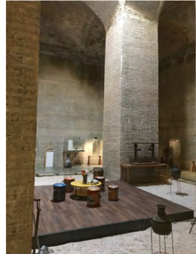
تصویر شماره ۱۶: ستون‌های آجری و روکش ملات ساروج جداره‌های درون مخزن سازه
