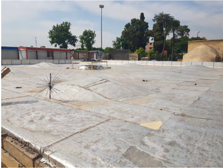
تصویر شماره ۶: ایزوگام کردن سقف آب‌انبار. مأخذ: رضوان یادگار تیرانی، ۲۸ اردیبهشت ۱۳۹۸.
