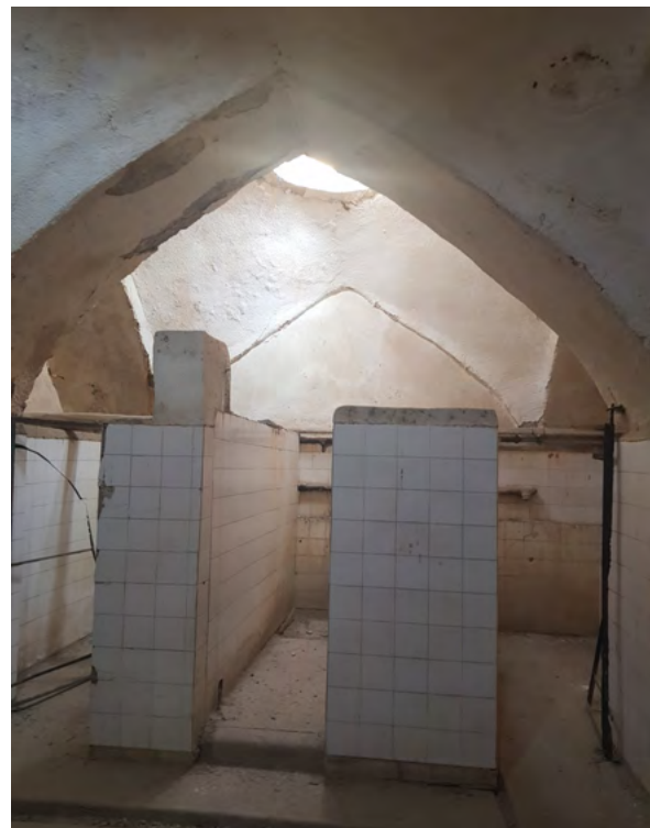
تصویر شماره ۳: دیوارکشی، لوله‌کشی و کاشی‌کاری در گرمخانه. مأخذ: رضوان یادگار تیرانی، ۱۳۹۸/۴/۱۷.
