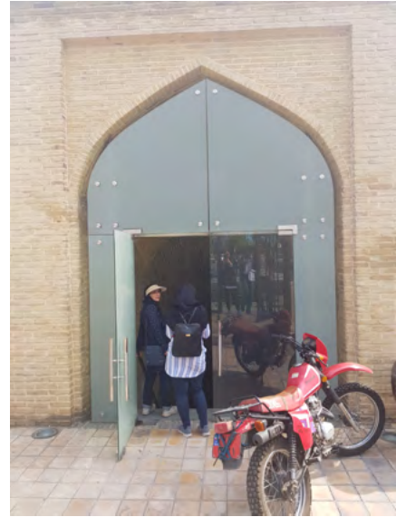
تصویر شماره ۵: نصب درب شیشه‌ای در ورودی آب‌انبار.
