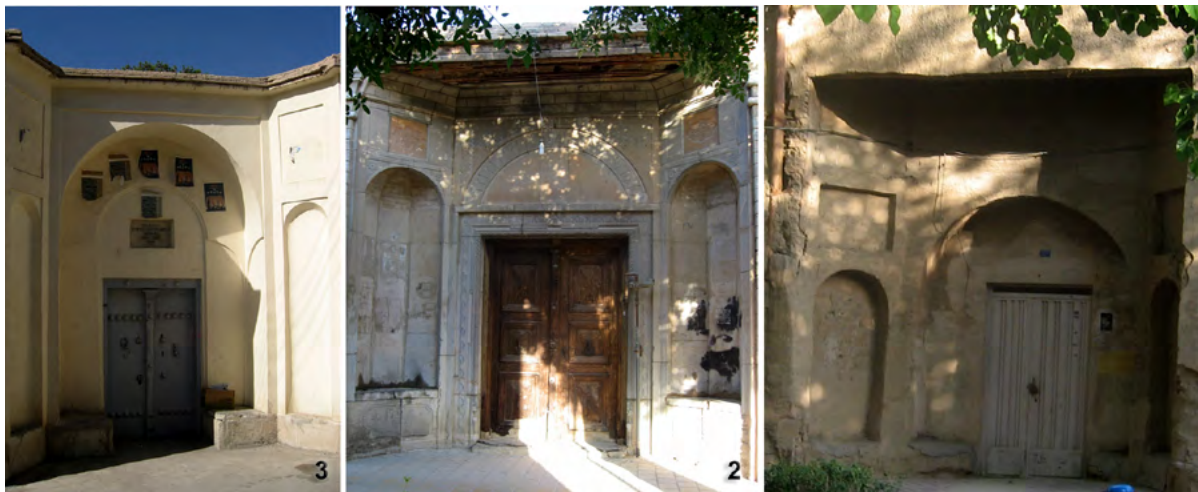
تصویر شماره ۱: جلوخان فضایی است در جلوی پیش طاق بعضی از بناهای مهم که برای اهمیت بخشیدن به فضای ورودی بنا و تمایز بهتر آن از معبر یا میدان ساخته می‌شود.
