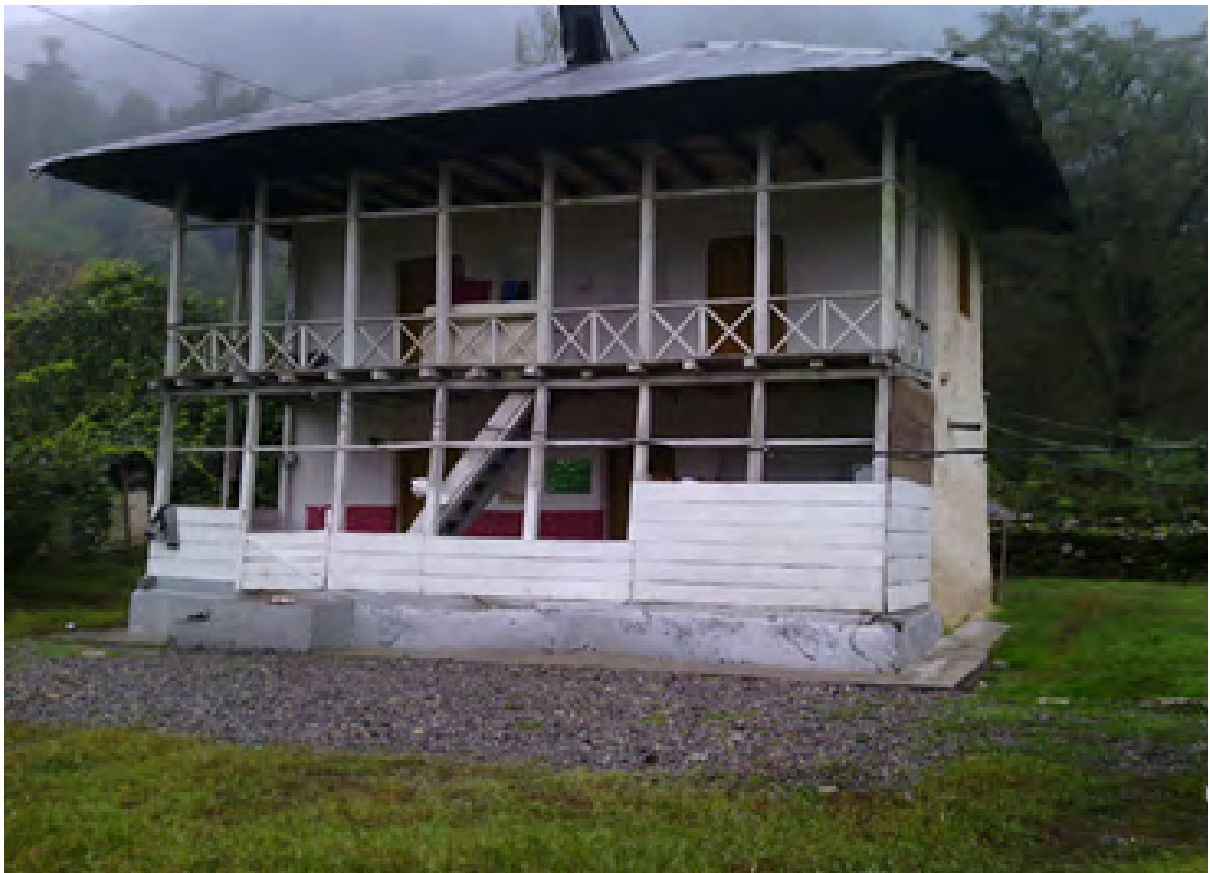
تصویر شماره ۴: نمای بنای شماره یک.
