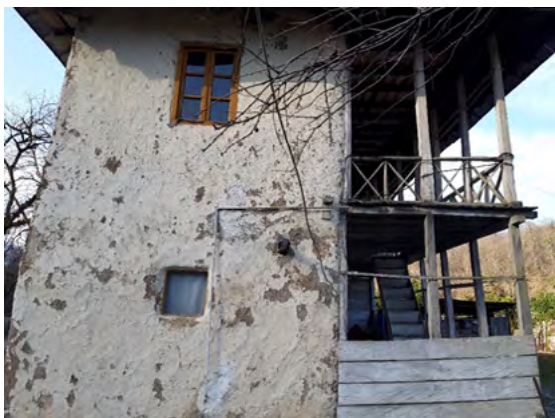
تصویر شماره ۷: فرم پنجره‌ها در بنای شماره یک در طبقه اول و قرار گیری آن در زاویه نورگیری.
