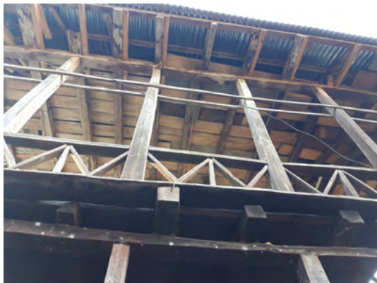
تصویر شماره ۱۶: توده‌ها و ستون‌های چوبی و اتصال آن‌ها به هم در بنای شماره دو.
