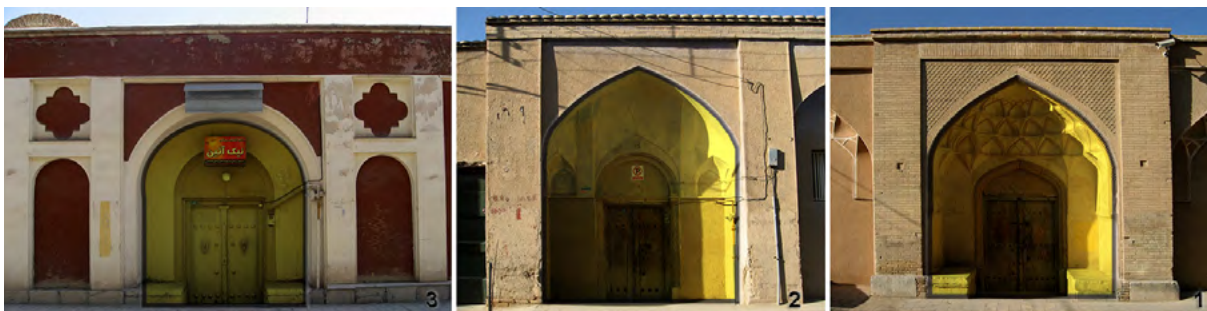
تصویر شماره ۳: پیش طاق (مشخص شده با رنگ زرد) فضایی سرپوشیده و نیمه‌باز مانند ایوان است که فضای دسترسی را از فضای معبر متمایز می‌نماید.
