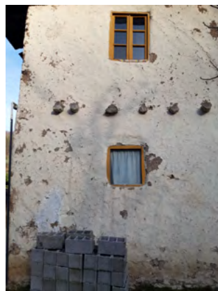
تصویر شماره ۶: نمای خارجی بنای شماره یک که دیوار خارجی آن با گل آلود شده
