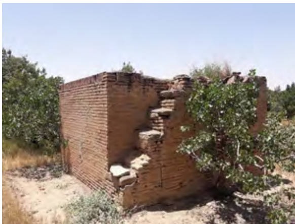
تصویر شماره ۱۴: راه پله آجری دسترسی به بام.
