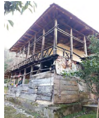
تصویر شماره ۱۱: نمای بنای شماره دو و ب کارگیری چوب به عنوان سازه اصلی.
