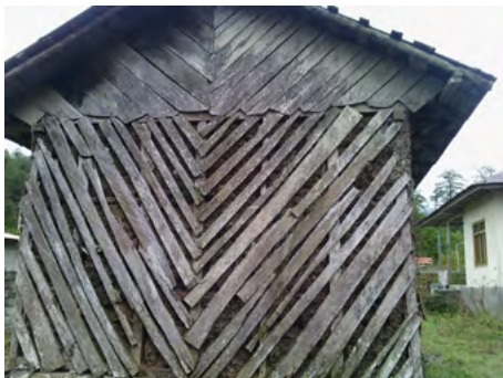
تصویر شماره ۳۱: ریزش اندود بنا که با رها کردن صاحب بنا به این شکل درآمده است.
