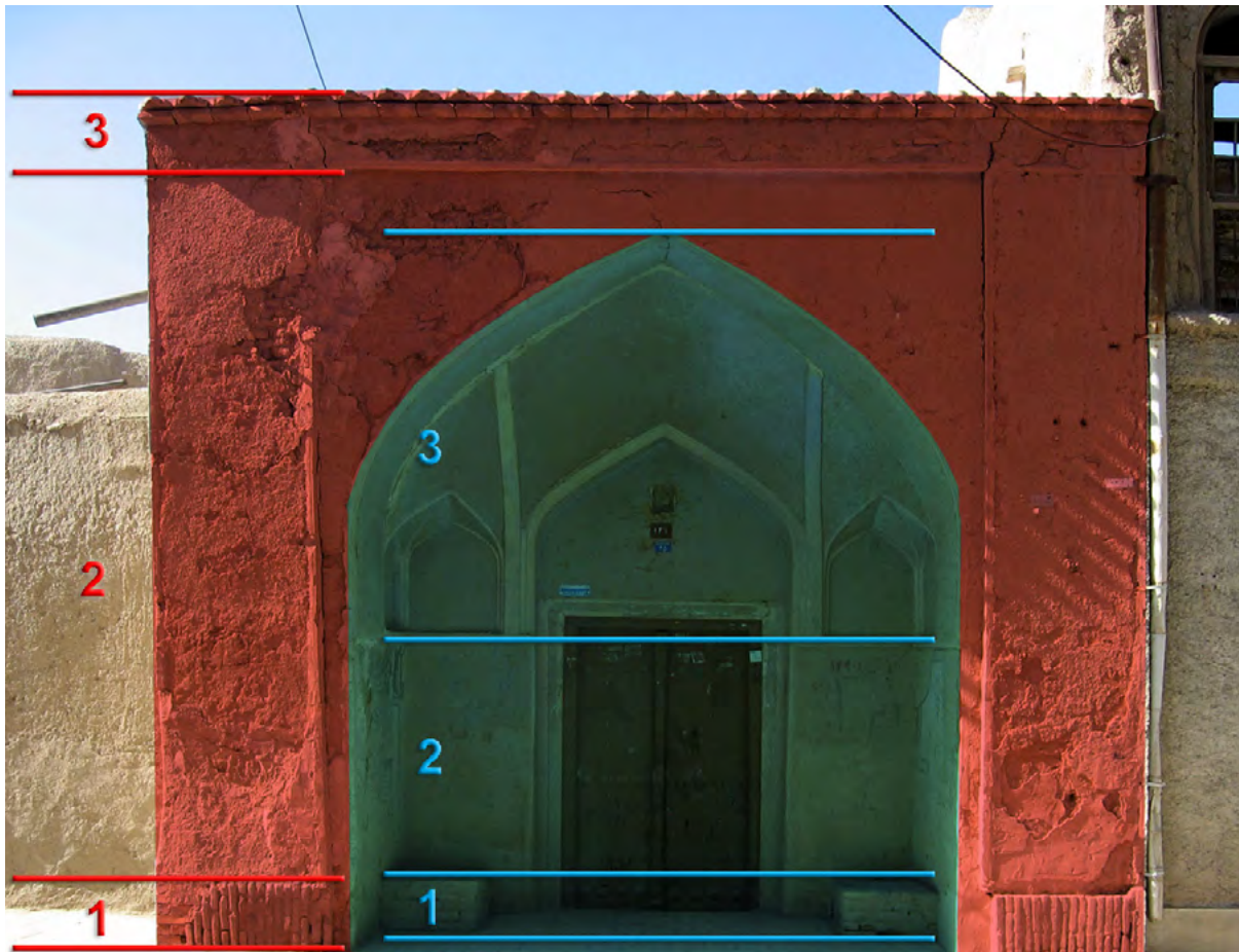
تصویر شماره ۴: در این مقاله به منظور سهولت، قسمت مشخص شده توسط رنگ قرمز را «سردر» و قسمت مشخص شده توسط رنگ آبی را «طاق» نامیده و هر کدام از آن‌ها را به سه قسمت «پی»، «ساقه» و «پیشانی» تقسیم نموده‌ام.
